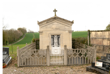
Chapelle funéraire de la famille d'Haudicourt et Cauvel de Beauvillé, vers 1865. Phot. Marc Kérignard IVR32_20266000059NUCA
