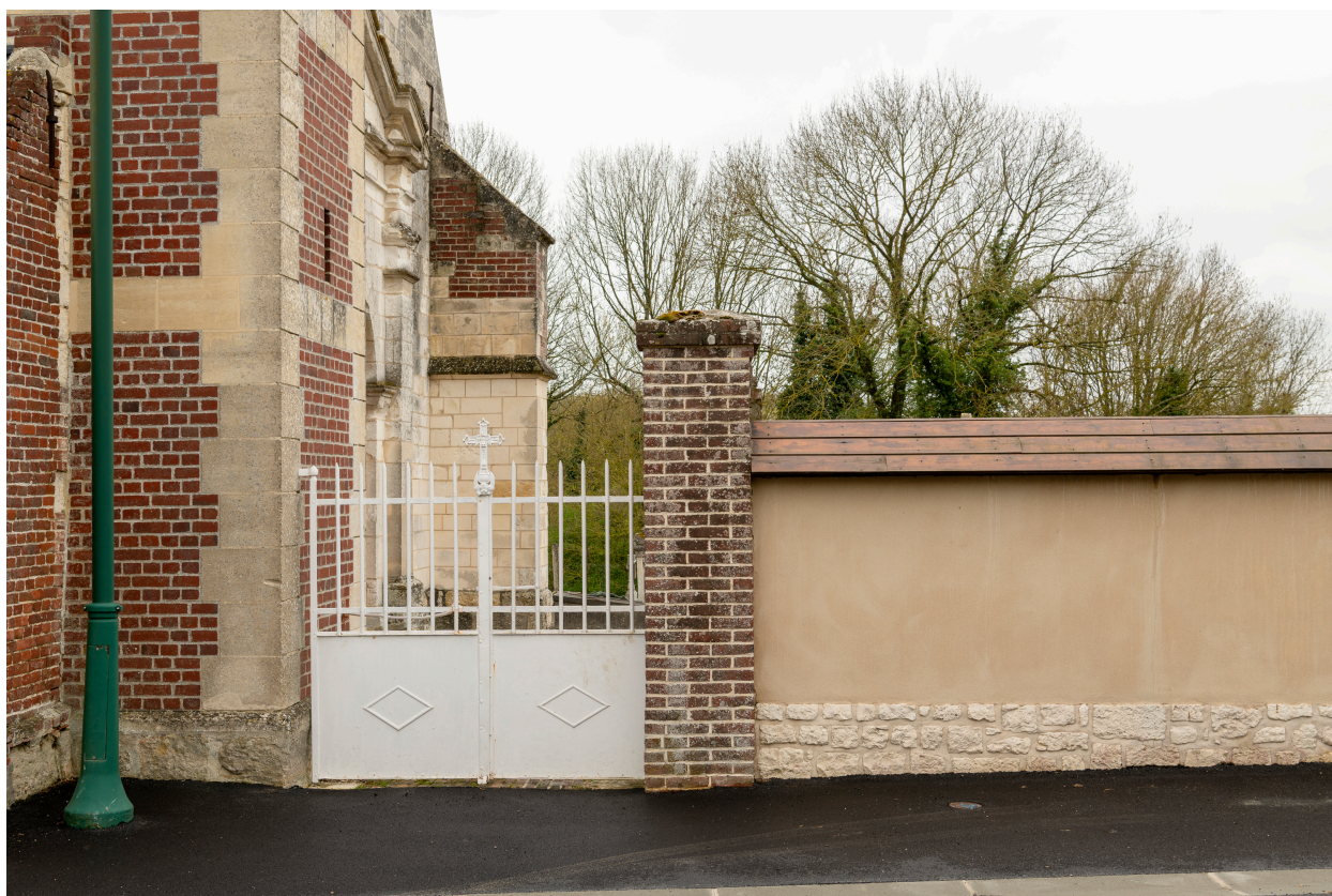
Entrée principale du cimetière, vue vers le sud.
