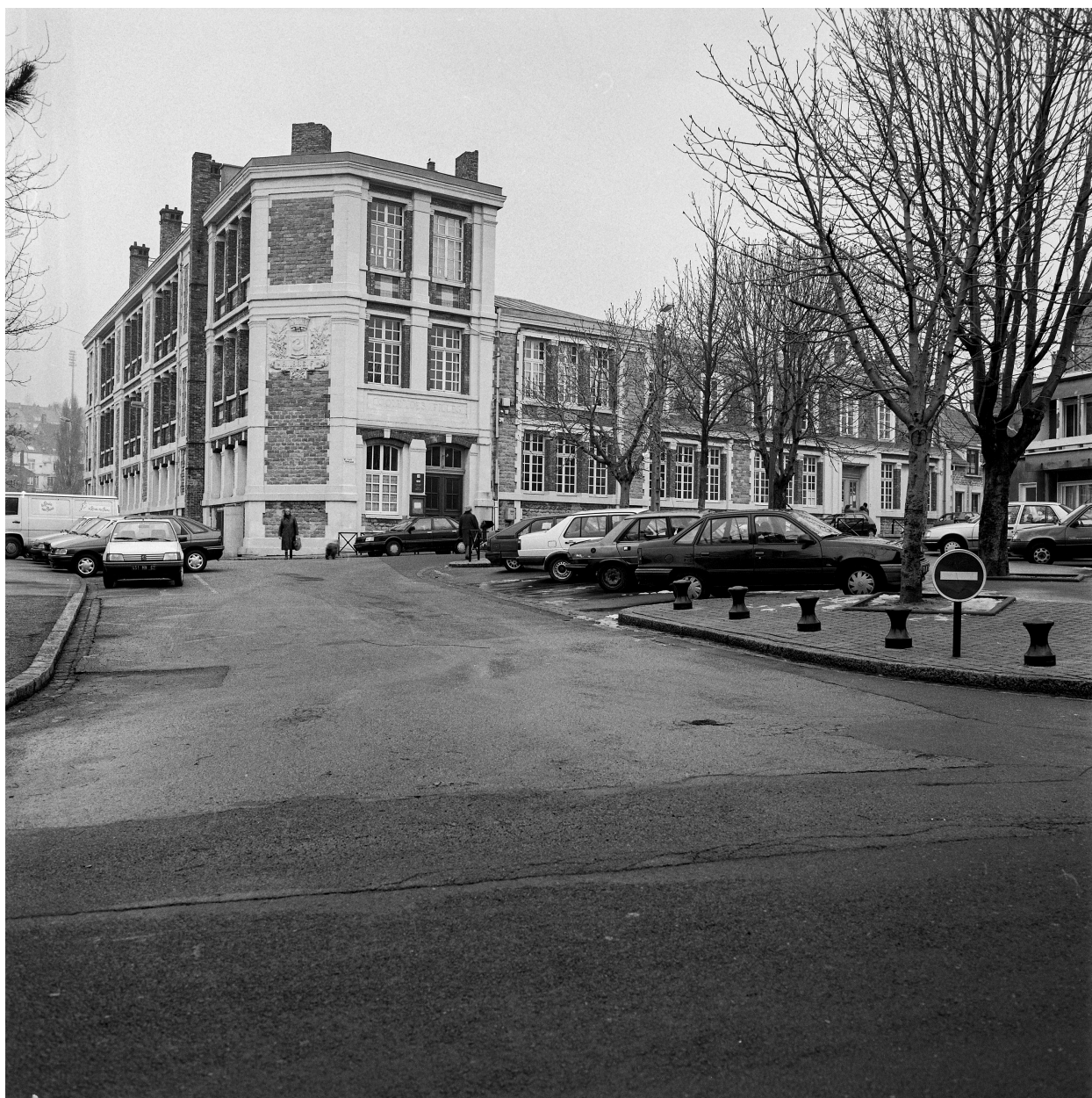
Vue générale d'angle.
