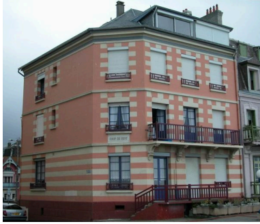
Vue d'ensemble depuis l'esplanade. Phot. Elisabeth Justome IVR22_20038005315NUCA
