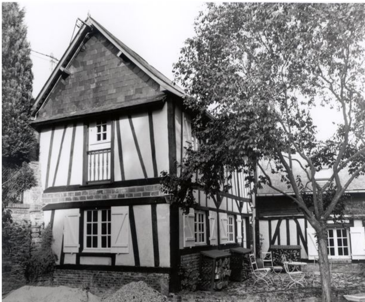
Façade sur cour du logement.
