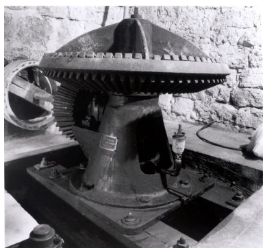
La turbine. Phot. Thierry Lefébure IVR22_20026001109X
