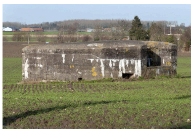
Vue de trois-quarts vers le nord. L'accès sur le pan coupé ainsi que le créneau de fusillade, à gauche, sont partiellement enterrés. Phot. Jean-Marc Ramette IVR31_20145904970NUCA
