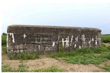
Elévation ouest Phot. Jean-Marc Ramette IVR31_20145904965NUCA
