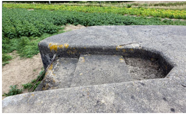
Cuve à mitrailleuse. Vue latérale Phot. Jean-Marc Ramette IVR31_20145904967NUCA
