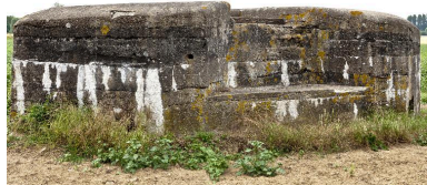
Vue de trois-quarts, vers le nord-ouest. Des échelons métalliques facilitent l'accès à la banquette de tir et à la mitrailleuse logée dans une cuvette polygonale, sur le couverture Phot. Jean-Marc Ramette IVR31_20145904964NUCA
