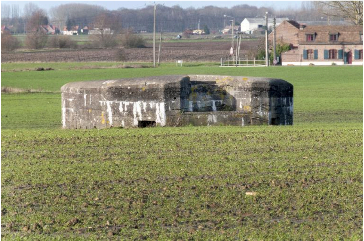
Vue générale vers le nord-ouest
