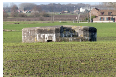
Vue générale vers le nord-ouest Phot. Jean-Marc Ramette IVR31_20145904969NUCA
