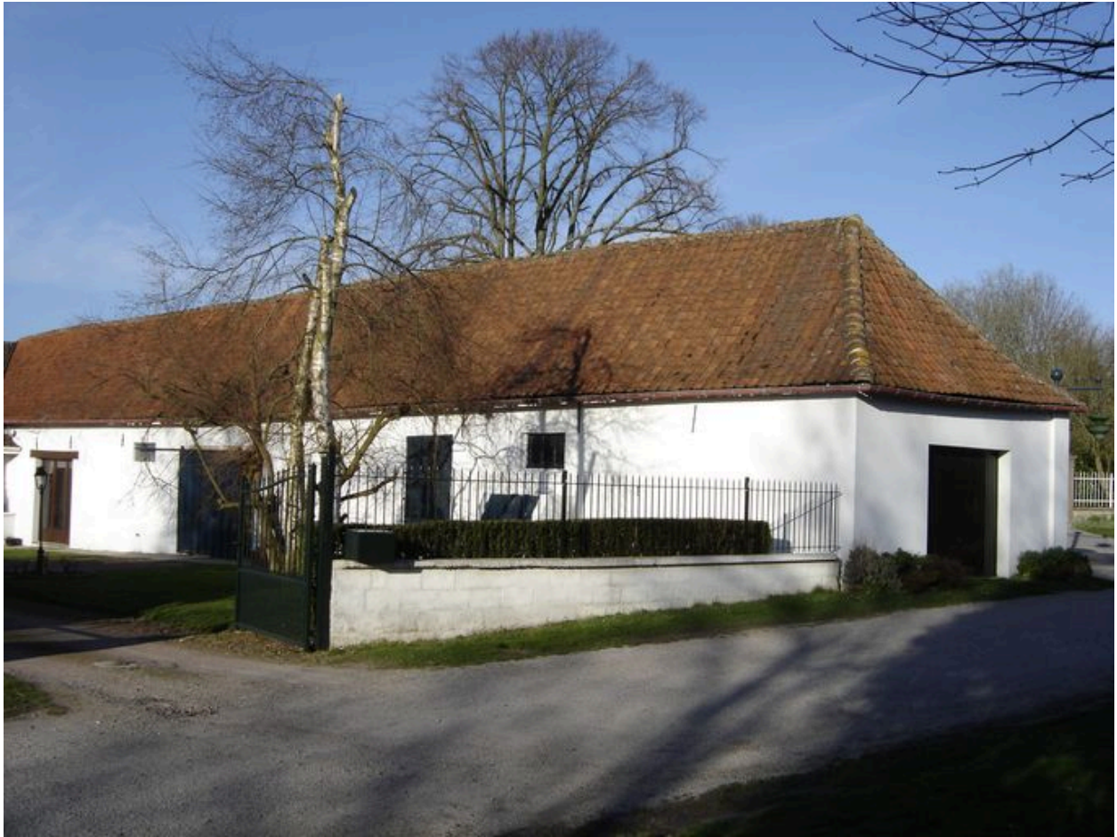
Vue des anciennes écuries depuis la rue du Riot.
