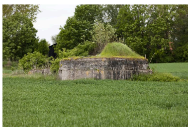
Vue latérale, vers l'ouest Phot. Jean-Marc Ramette IVR31_20145904329NUCA
