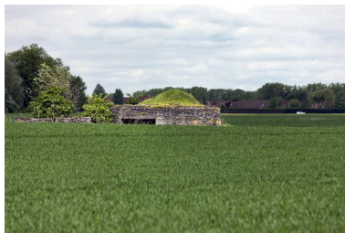
Vue vers le nord-ouest Phot. Jean-Marc Ramette IVR31_20145904327NUCA
