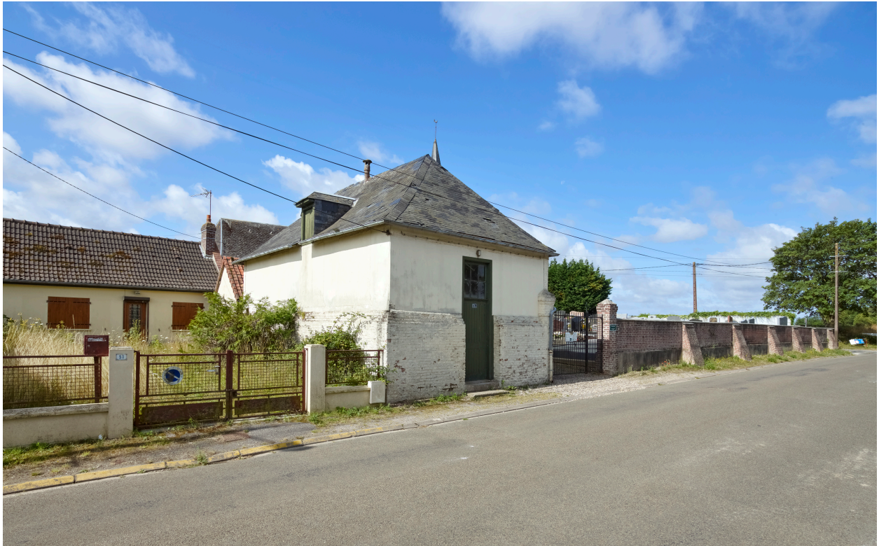
Vue nord de l'ancienne école, depuis la rue.
