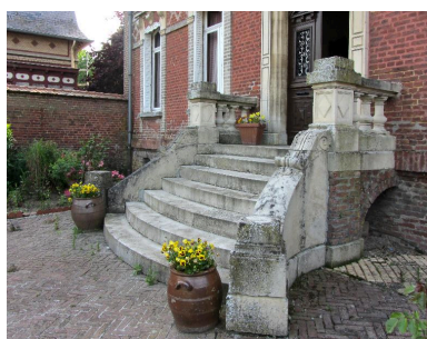
Détail de l'escalier. Phot. Bertrand Fournier IVR22_20138015748NUC2A
