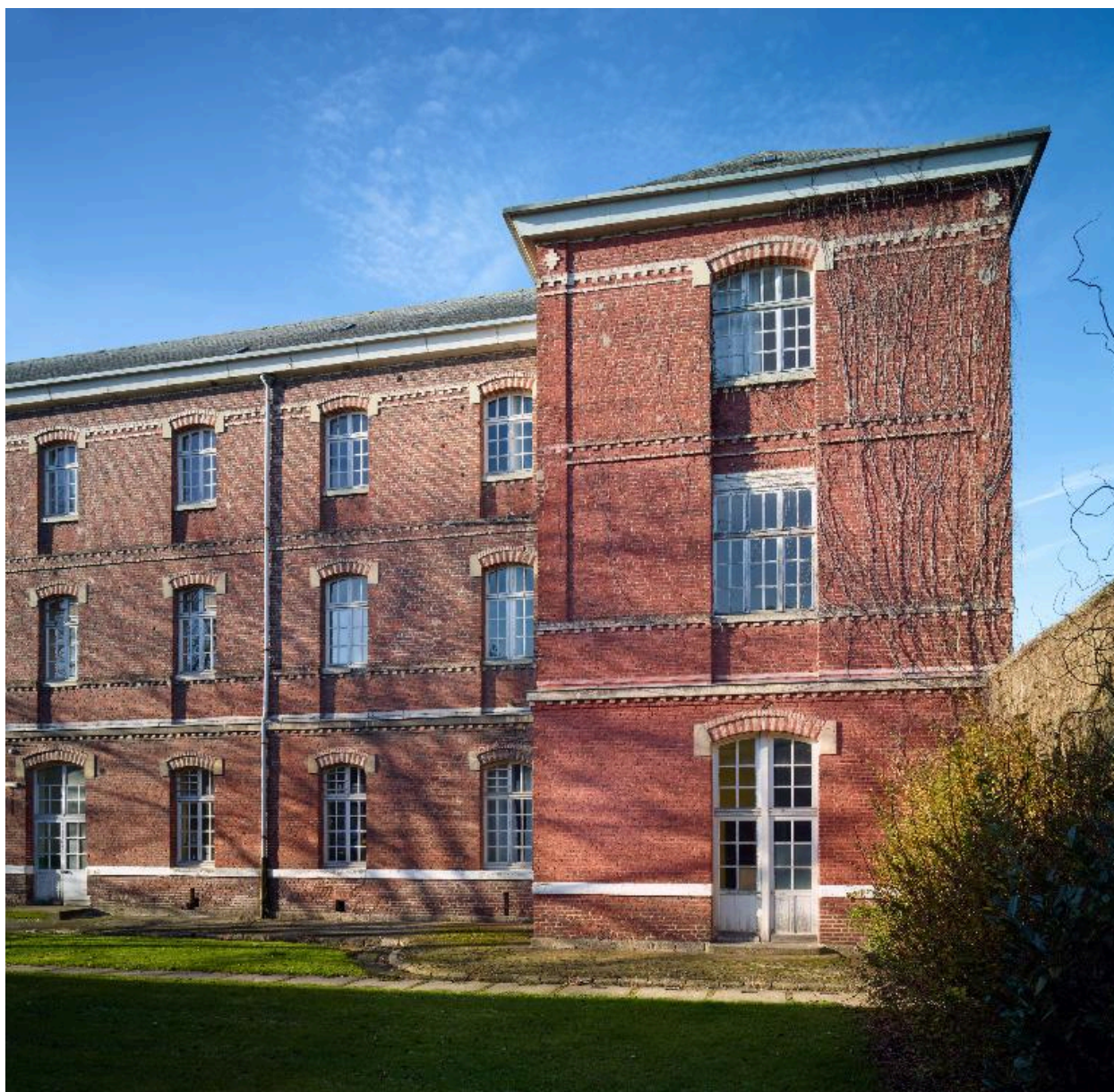
Bâtiment de malades dit pavillon 6, élévation antérieure donnant sur le jardin, extrémité droite, vue de face.
