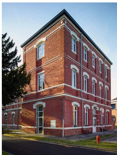
Bâtiment d'hospitalisation dit pavillon 9, élévation latérale droite donnant sur l'espace médian
