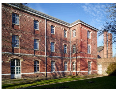
Bâtiment d'hospitalisation dit pavillon 6, élévation antérieure donnant sur le jardin, moitié droite, vue de trois quarts gauche. Phot. Pierre Thibaut IVR32_20176200010NUCA
