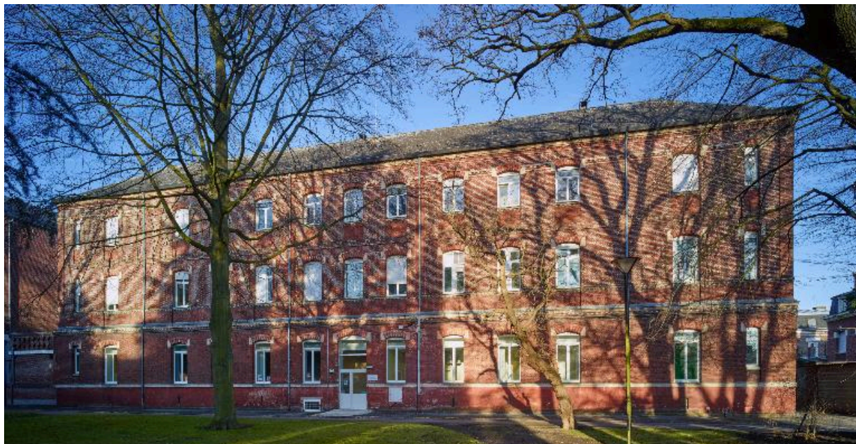
Bâtiment d'hospitalisation dit pavillon 1, élévation antérieure, vue de face.
