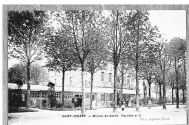
Bâtiment d'hospitalisation dit pavillon 2, élévation latérale donnant sur la grande allée médiane de l'établissement, vue montrant, au premier plan, la galerie de service reliant entre eux les pavillons qui étaient alors encore en place (coll. part.).
