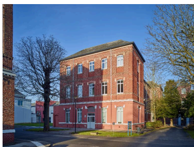
Bâtiment d'hospitalisation dit pavillon 2, élévation latérale gauche donnant sur l'espace médian formant l'axe de l'établissement, vue de trois quarts droit. Phot. Pierre Thibaut IVR32_20176200027NUCA
