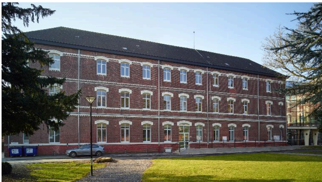
Bâtiment d'hospitalisation dit pavillon 10, élévation antérieure, vue générale prise de trois quarts gauche.
