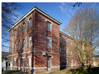
Bâtiment d'hospitalisation dit pavillon 6, élévations antérieure et latérale gauche donnant sur le jardin, vue d'ensemble. Phot. Pierre Thibaut IVR32_20176200011NUCA
