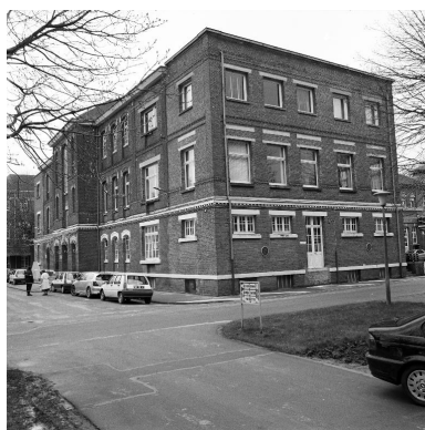
Bâtiment de l'administration, élévation antérieure, vue générale prise de trois quarts droit. Phot. Philippe Dapvril
