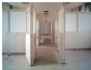
Bâtiment d'hospitalisation dit pavillon 6, 1er étage, vue générale prise en enfilade d'une ancienne salle commune subdivisée ultérieurement par des boxes en compartiments renfermant seulement 2 à 4 lits.
