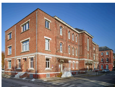
Bâtiment de l'administration, élévation antérieure, vue générale prise de trois quarts gauche. Phot. Pierre Thibaut IVR32_20176200041NUCA
