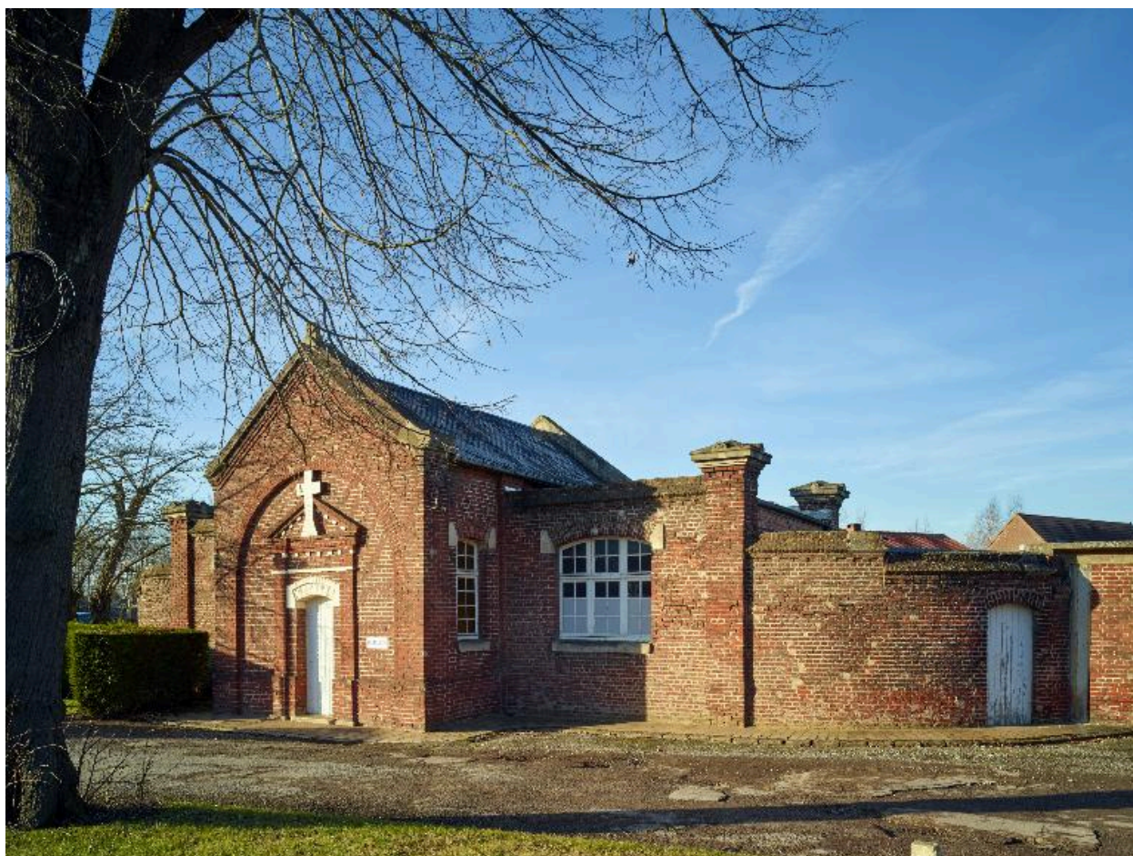
Morgue, façade antérieure, vue générale prise de trois quarts droit.
