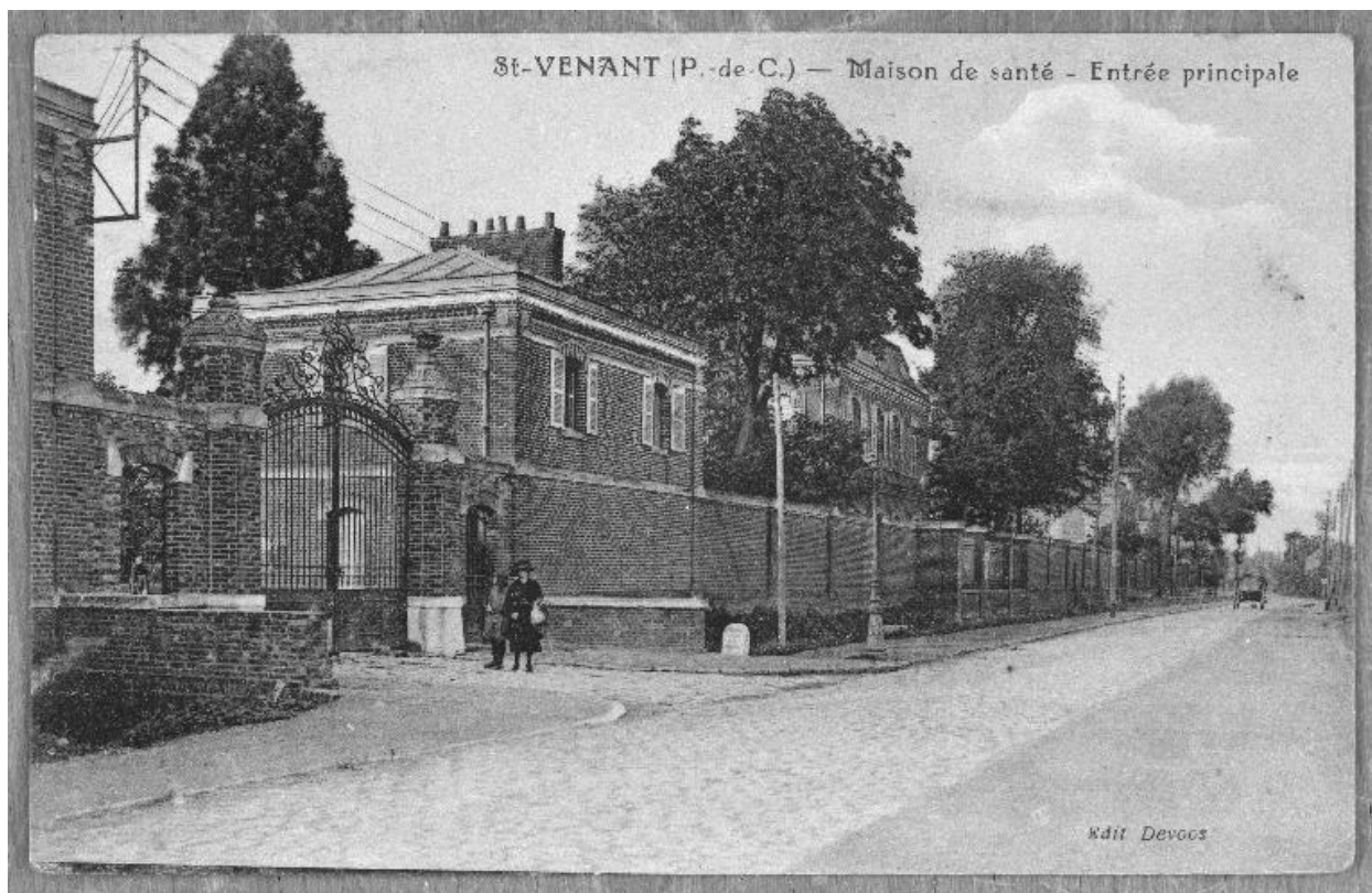
Entrée principale encadrée des deux pavillons de la conciergerie, élévation antérieure donnant sur la route, vue de trois quarts gauche (coll. part.).
