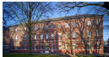
Bâtiment d'hospitalisation dit pavillon 1, élévation antérieure, vue de face. Phot. Pierre Thibaut IVR32_20176200031NUCA
