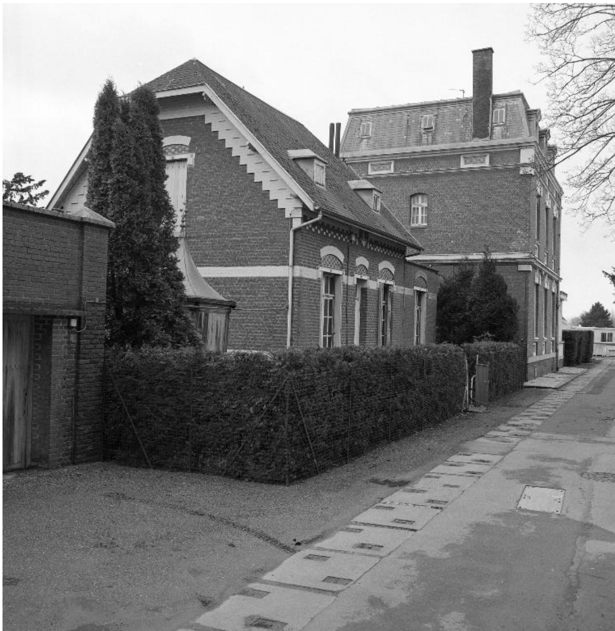
Deux des logements de fonction sis à gauche de l'entrée, désignés sous le nom de pavillons 24 et 25, élévation sur l'allée de desserte interne à l'hôpital, vue d'ensemble prise en enfilade.
