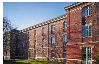
Bâtiment de malades dit pavillon 6, élévation antérieure donnant sur le jardin, vue générale prise de trois quarts droit. Phot. Pierre Thibaut IVR32_20176200035NUCA
