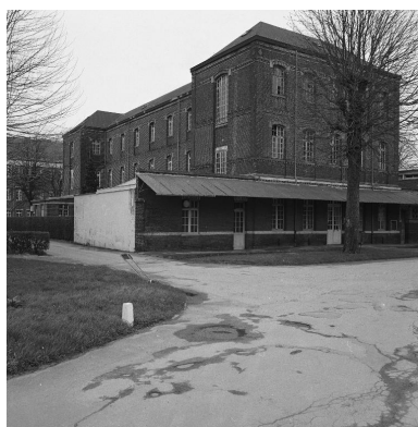
Bâtiment d'hospitalisation dit pavillon 5, élévation latérale gauche, vue de trois quarts gauche, avec l'élévation postérieure vue en enfilade. Phot. Philippe Dapvril IVR31_20026200045X
