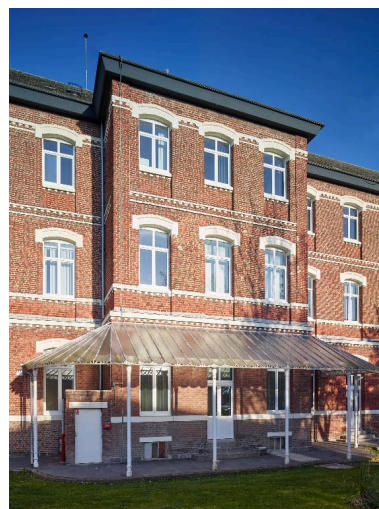
Bâtiment d'hospitalisation dit pavillon 10, élévation postérieure, détail de l'avant-corps central.
