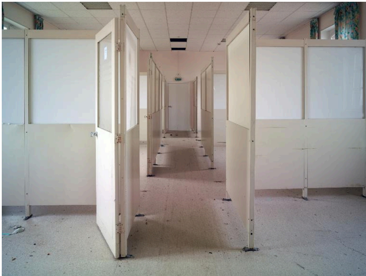
Bâtiment d'hospitalisation dit pavillon 6, 1er étage, vue générale prise en enfilade d'une ancienne salle commune subdivisée ultérieurement par des boxes en compartiments renfermant seulement 2 à 4 lits.
