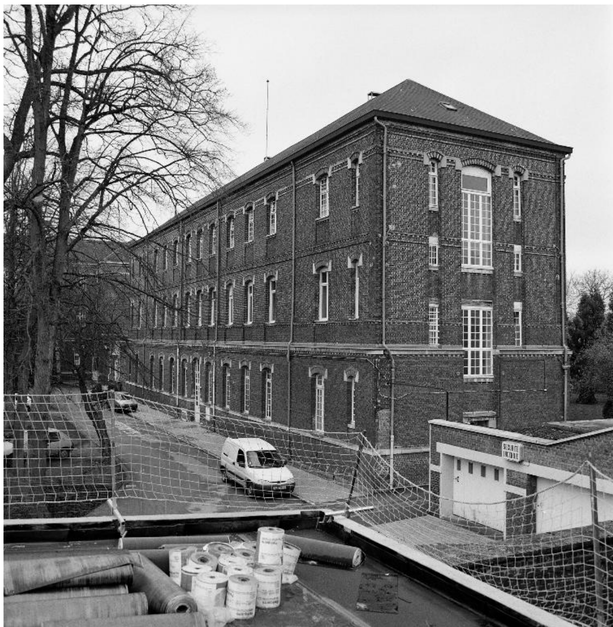
Bâtiment d'hospitalisation dit pavillon 1, élévation antérieure, vue générale prise de trois quarts droit.
