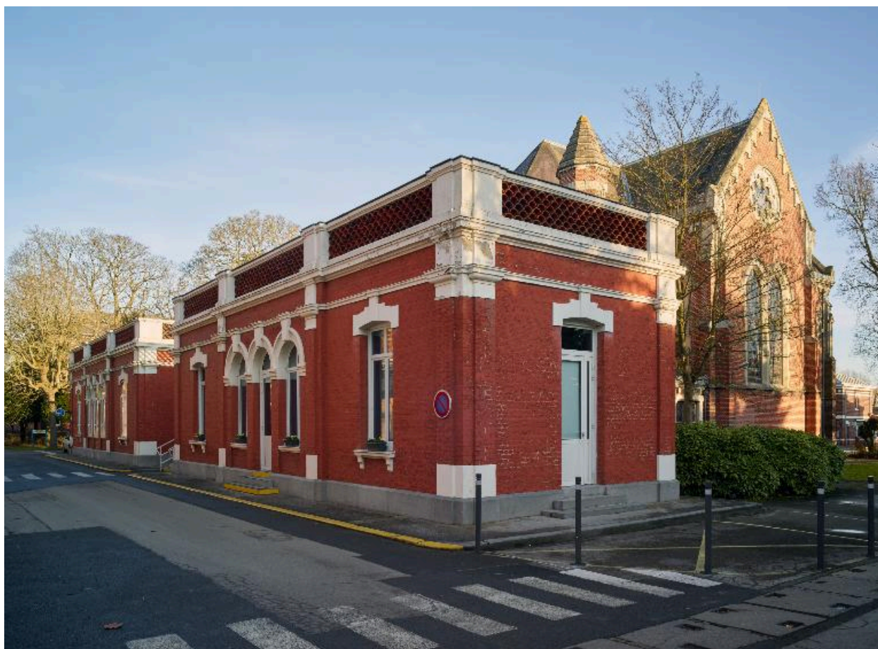
Série de deux bâtiments en rez-de-chaussée qui abritaient respectivement le parloir et la salle des commissions, élévations postérieures, vue d'ensemble prise en enfilade.
