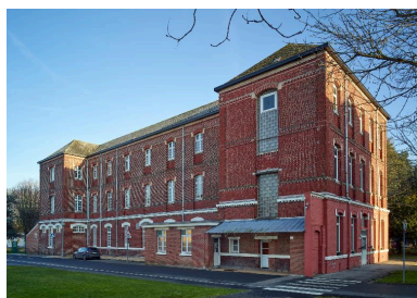
Bâtiment d'hospitalisation dit pavillon 2, élévation postérieure, vue générale prise de trois quarts droit. Phot. Pierre Thibaut IVR32_20176200029NUCA
