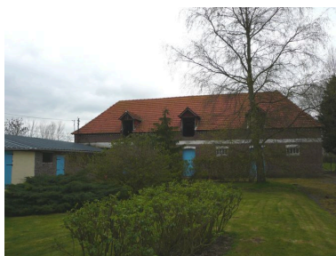
Vue des bâtiments agricoles. Phot. Inès Guérin IVR22_20078005718NUCA
