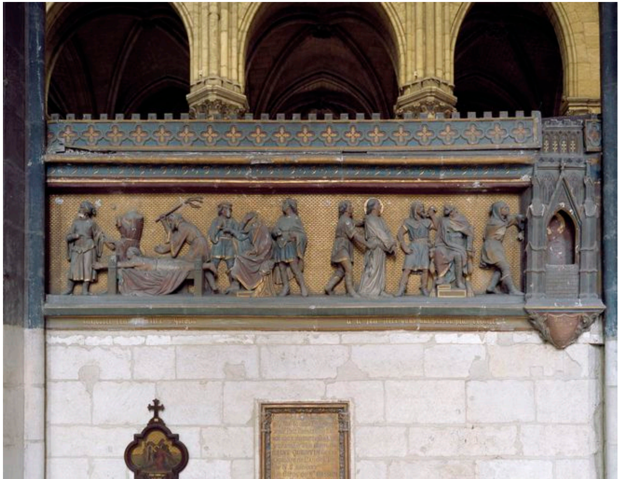
Vue de la troisième travée sud.
