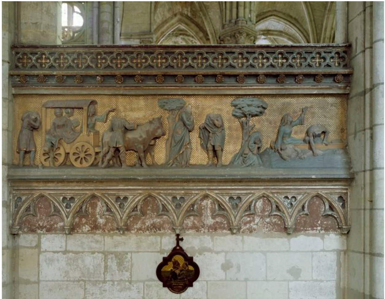
Vue de la quatrième travée nord.
