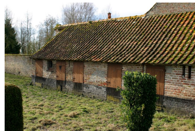
Vue des porcheries. Phot. Irwin Leullier IVR22_20078000158NUCA
