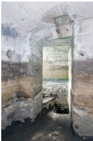
Vue intérieure de l'entrée ouest. Au sol un puisard, au plafond, le conduit du périscopes Phot. Pierre Thibaut IVR31_20155901481NUCA
