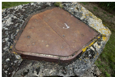
Observatoire bétonné, couverture Phot. Jean-Marc Ramette IVR31_20145904678NUCA
