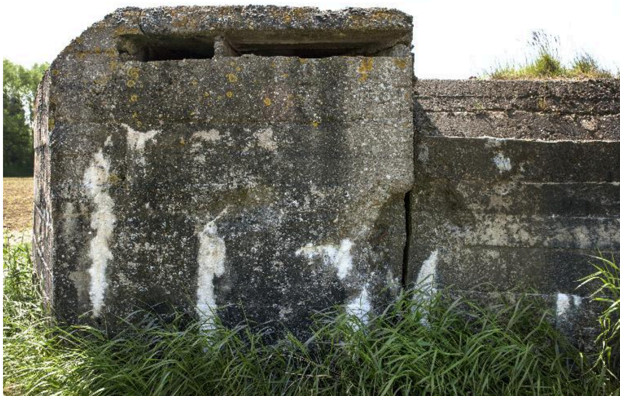
Arrière de l'observatoire casematé
