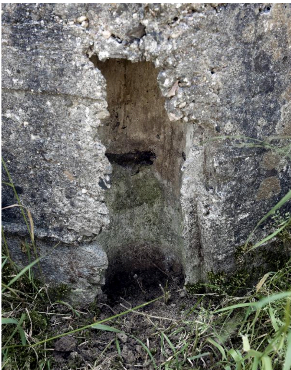
Elévation nord : empreinte de piquet de coffrage
