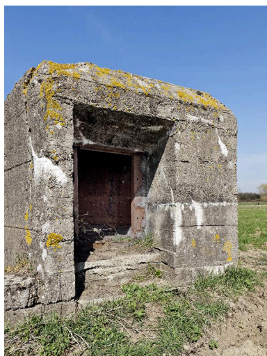
Entrée de l'observatoire casematé Phot. Jean-Marc Ramette IVR31_20145904700NUCA
