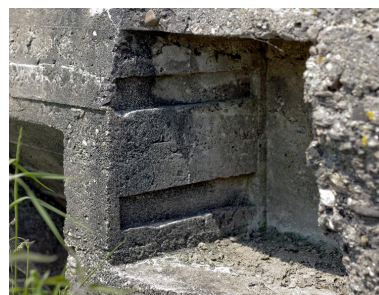
Niches à munitions. Les rainures correspondent à l'empreinte de la caisse ayant servi de gabarit Phot. Jean-Marc Ramette IVR31_20145904669NUCA
