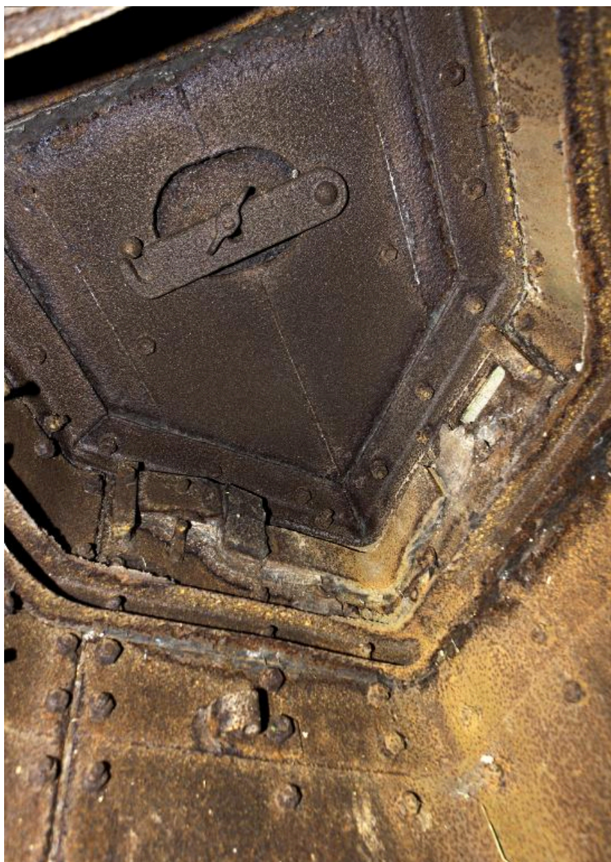
Observatoire casematé, vue intérieure du couvrement cuirassé
