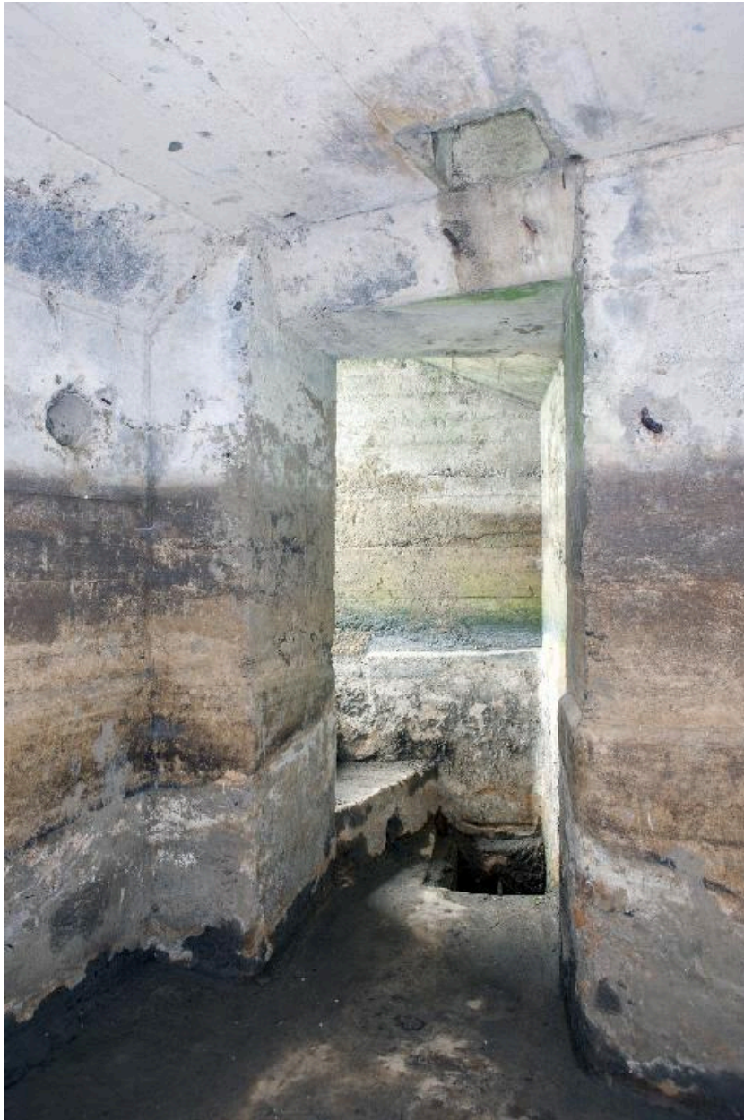
Vue intérieure de l'entrée ouest. Au sol un puisard, au plafond, le conduit du périscope
