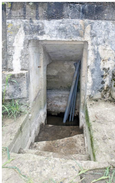
Entrée est Phot. Pierre Thibaut IVR31_20155901485NUCA
