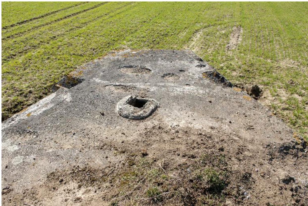
Couvrement, cheminée du périscope
