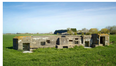
Etat de l'édifice en 2019. Les entrées ont été condamnées par la mairie pour raisons de sécurité. Phot. Pierre Thibaut IVR32_20195900258NUCA
