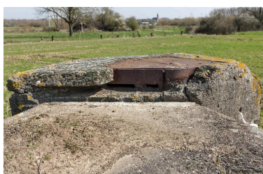
Profil de l'observatoire cuirassé Phot. Jean-Marc Ramette IVR31_20145904686NUCA
