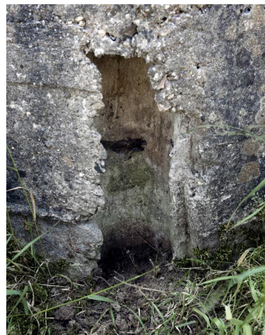
Elévation nord : empreinte de piquet de coffrage Phot. Jean-Marc Ramette IVR31_20145904671NUCA
