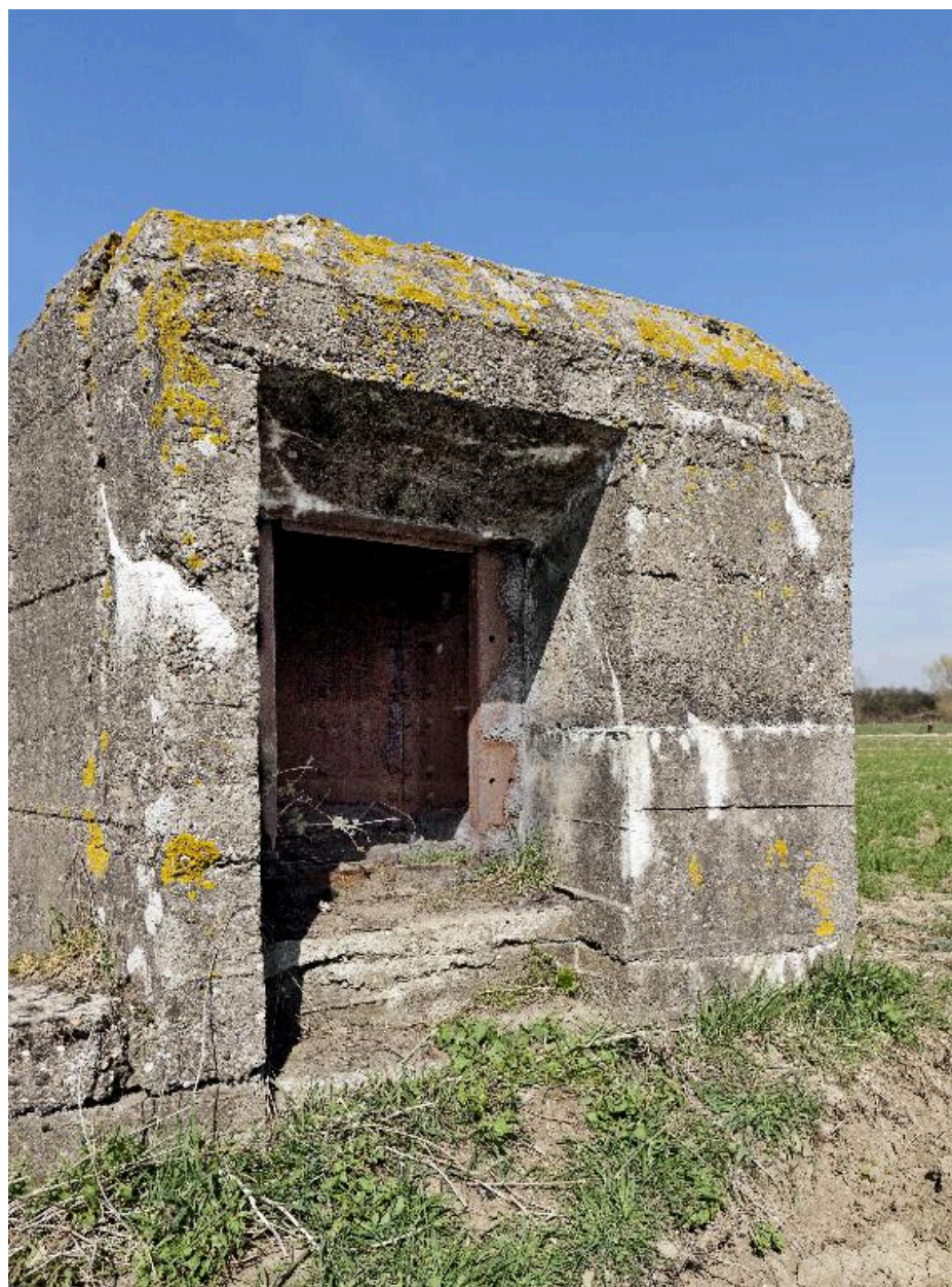
Entrée de l'observatoire casematé
