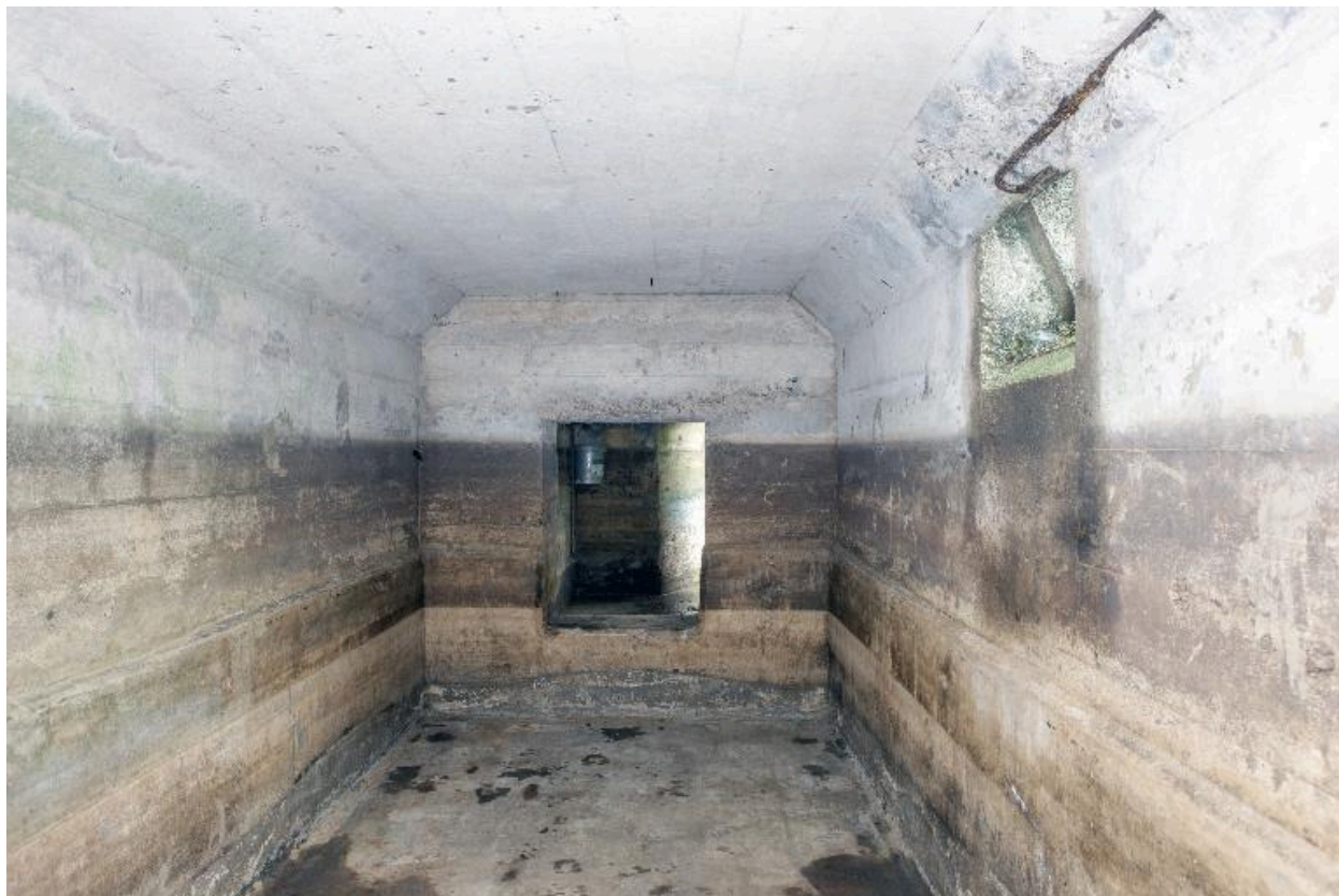
vue intérieure, salle ouest
