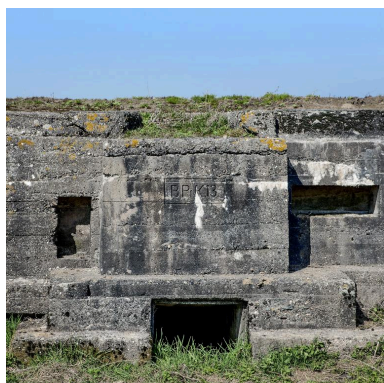
Élévation sud : Banquette de tir encadrée de niches à munition. Au niveau du sol, la resserre à mitrailleuse Phot. Jean-Marc Ramette IVR31_20145904683NUCA
