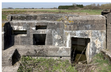
Entrée est, conduit d'aération (?) et niches à munitions Phot. Jean-Marc Ramette IVR31_20145904699NUCA
