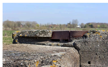
Profil de l'observatoire cuirassé Phot. Jean-Marc Ramette IVR31_20145904695NUCA
