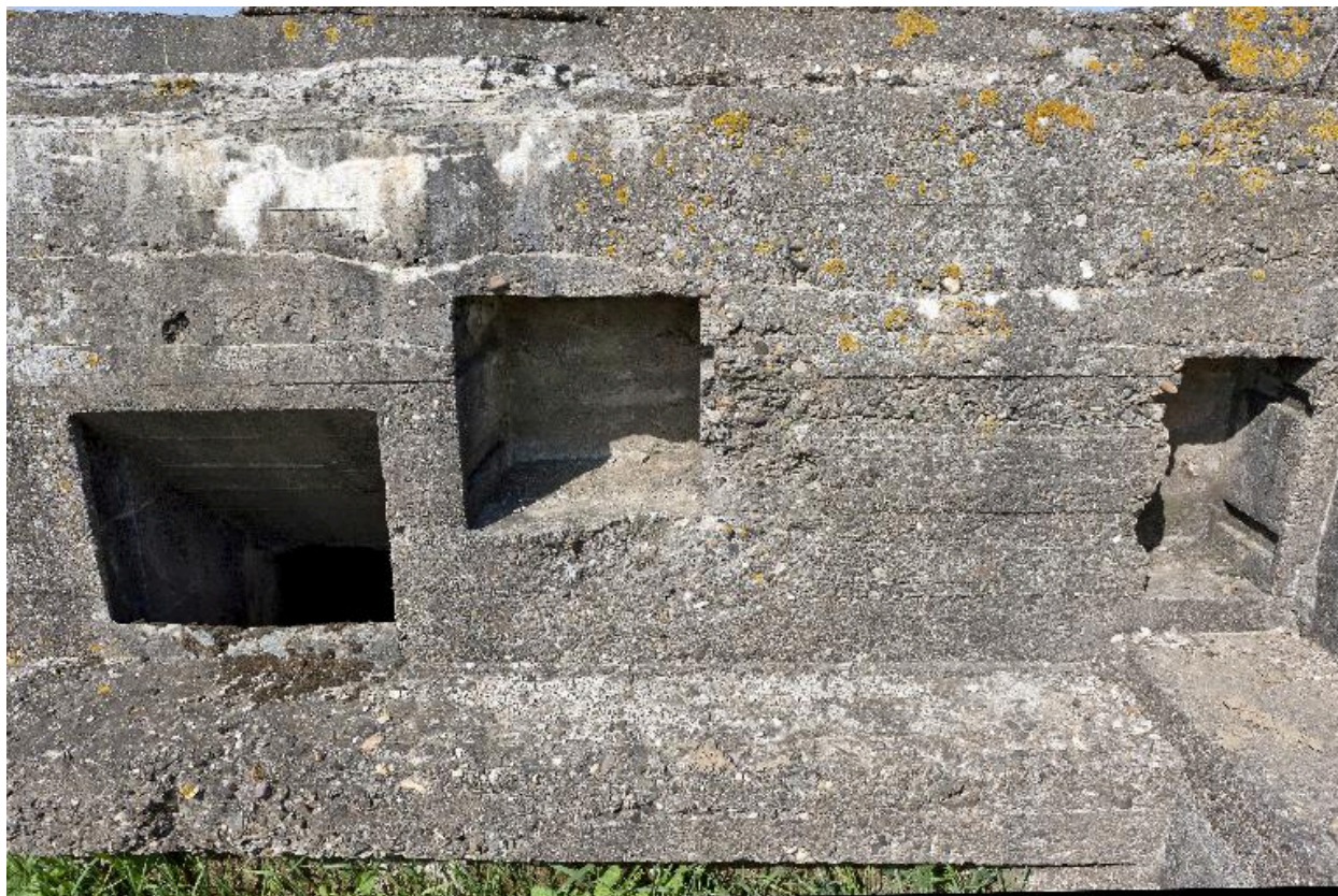
De gauche à droite : Conduit d'aération (?) et niches à munitions
