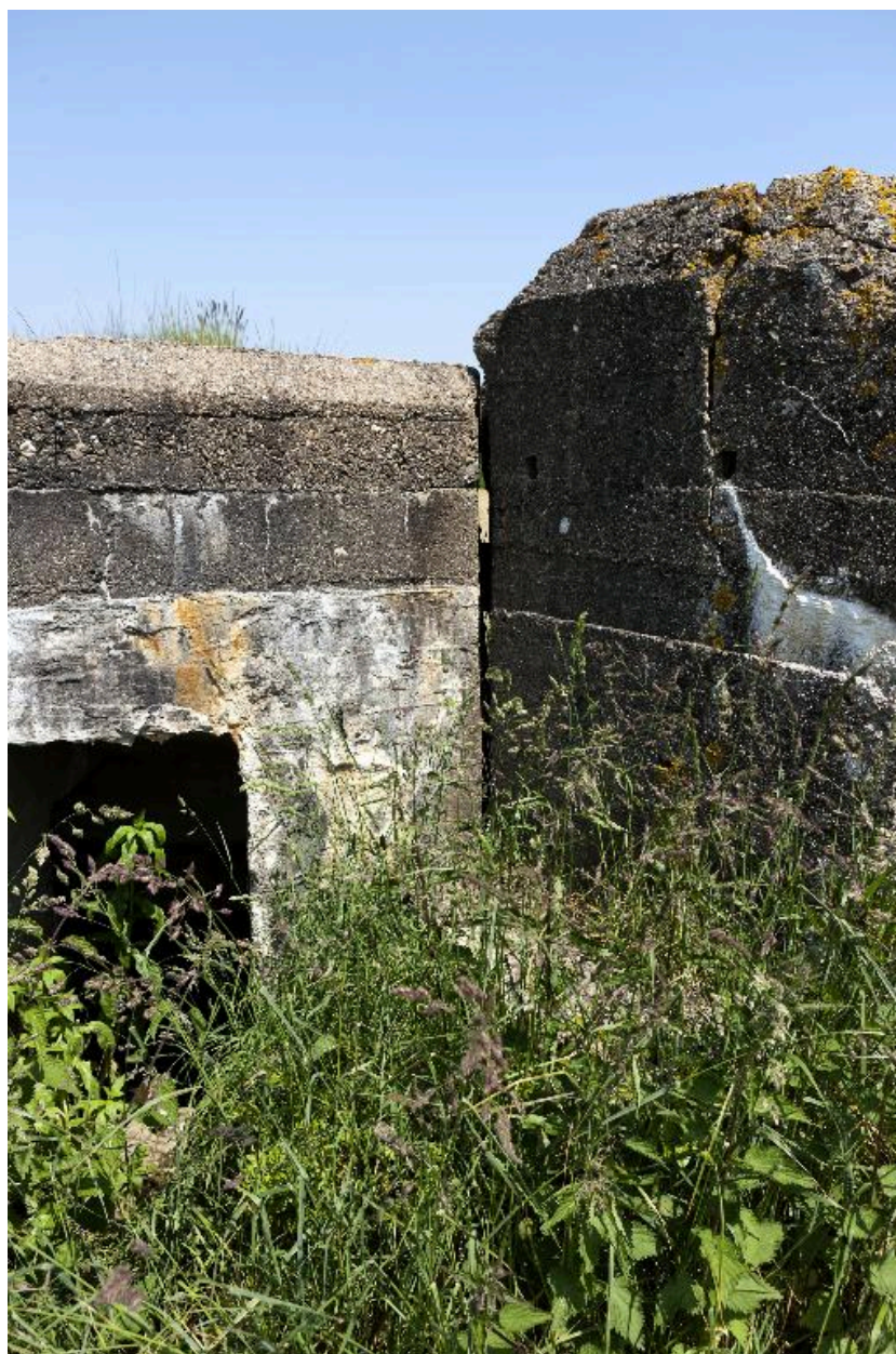
Jonction de l'abri avec l'observatoire casematé
