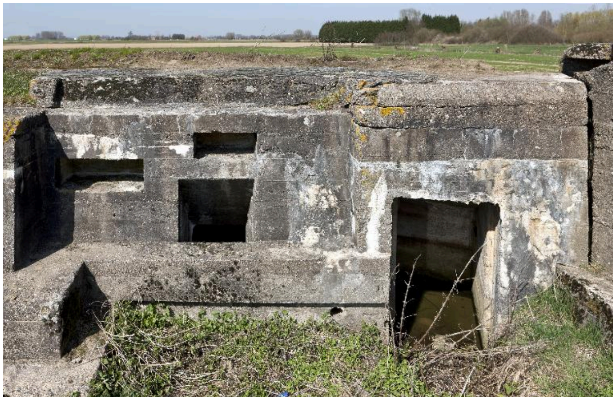
Entrée est, conduit d'aération (?) et niches à munitions
