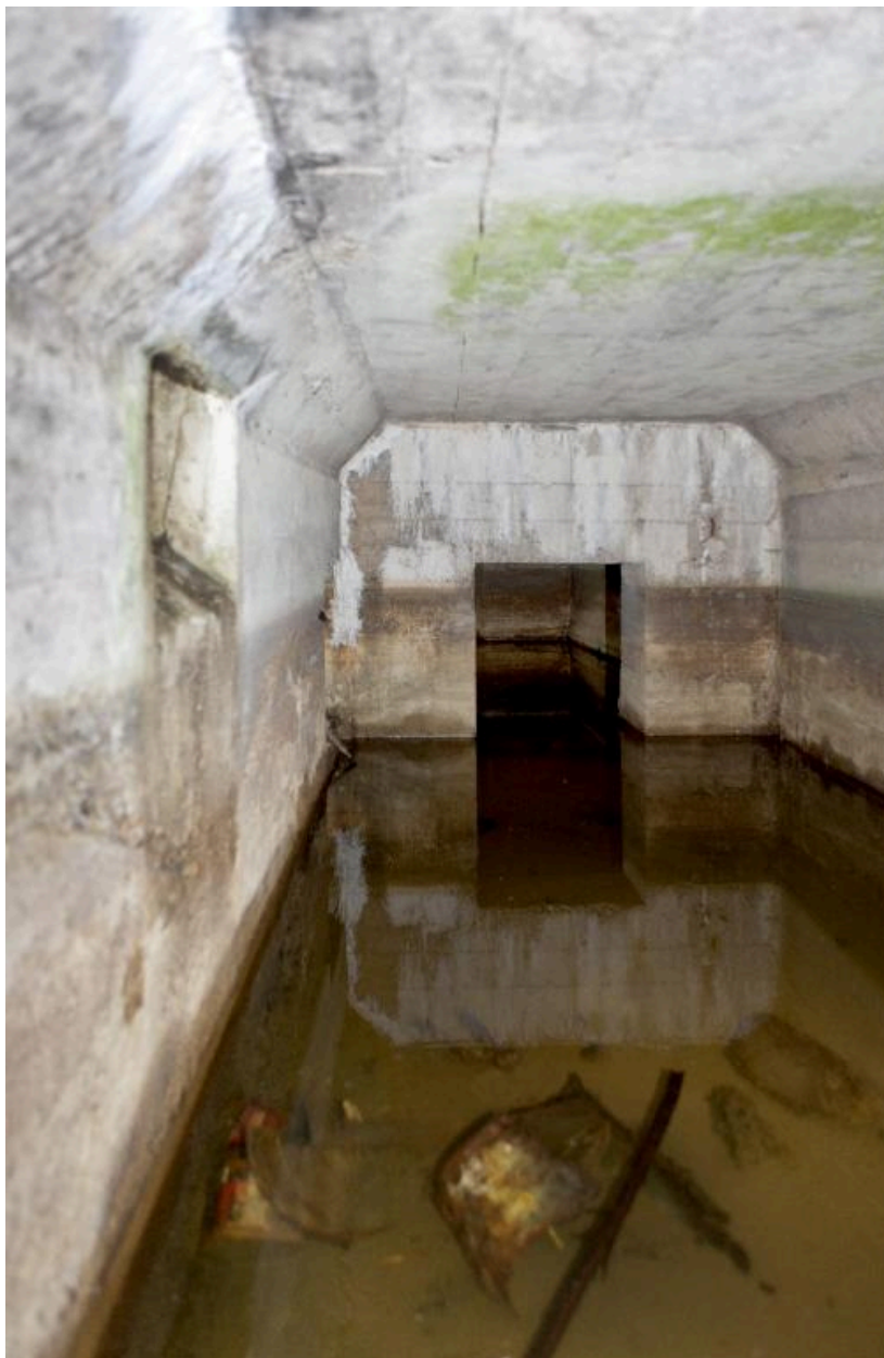
Vue en enfilade des deux salles de l'abri, depuis l'entrée est
