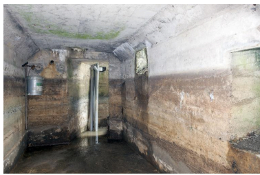
Vue intérieure, salle est Phot. Pierre Thibaut IVR31_20155901480NUCA
