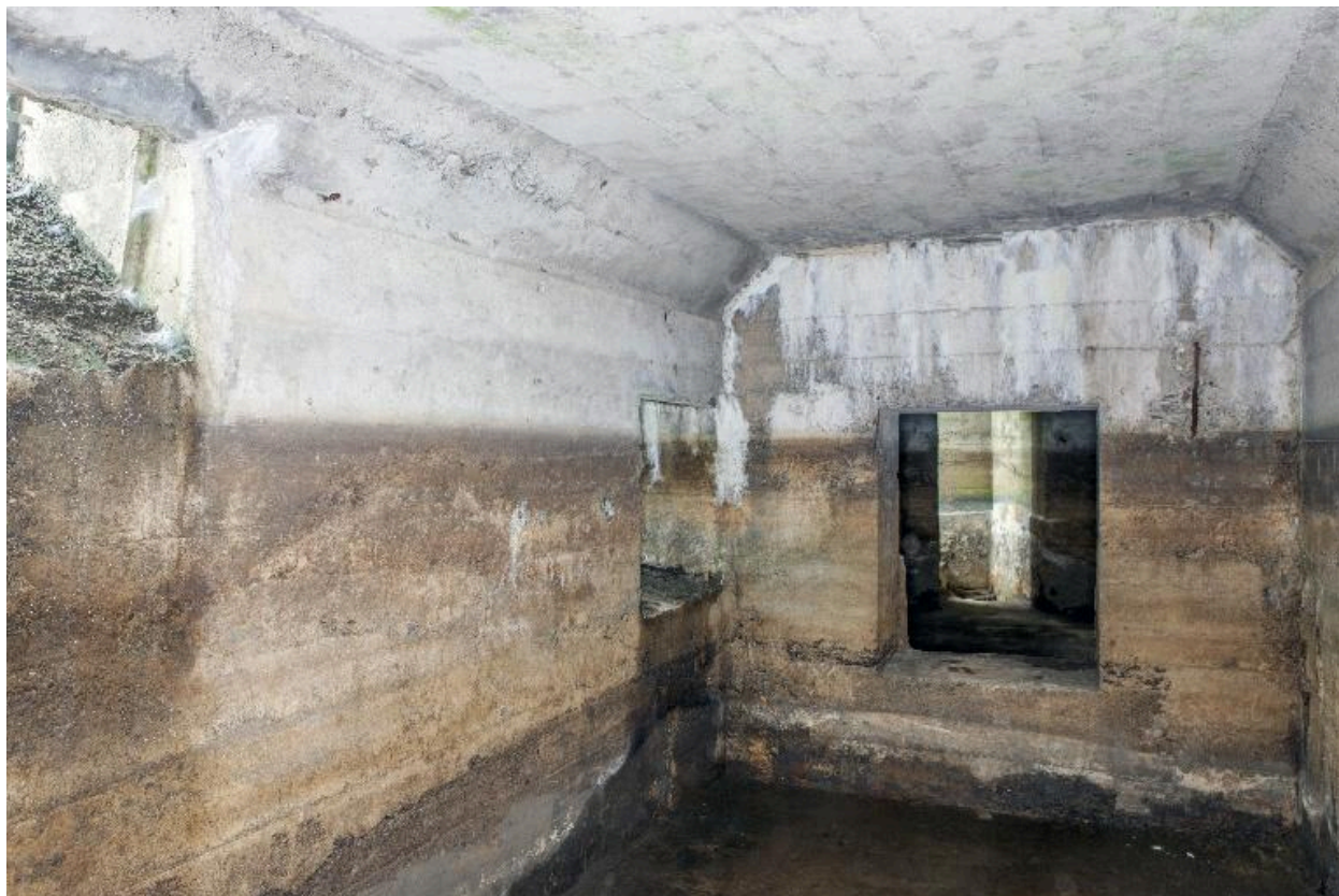
Vue intérieur de l'abri vers l'entrée ouest
