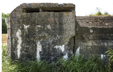
Arrière de l'observatoire casematé Phot. Jean-Marc Ramette IVR31_20145904670NUCA
