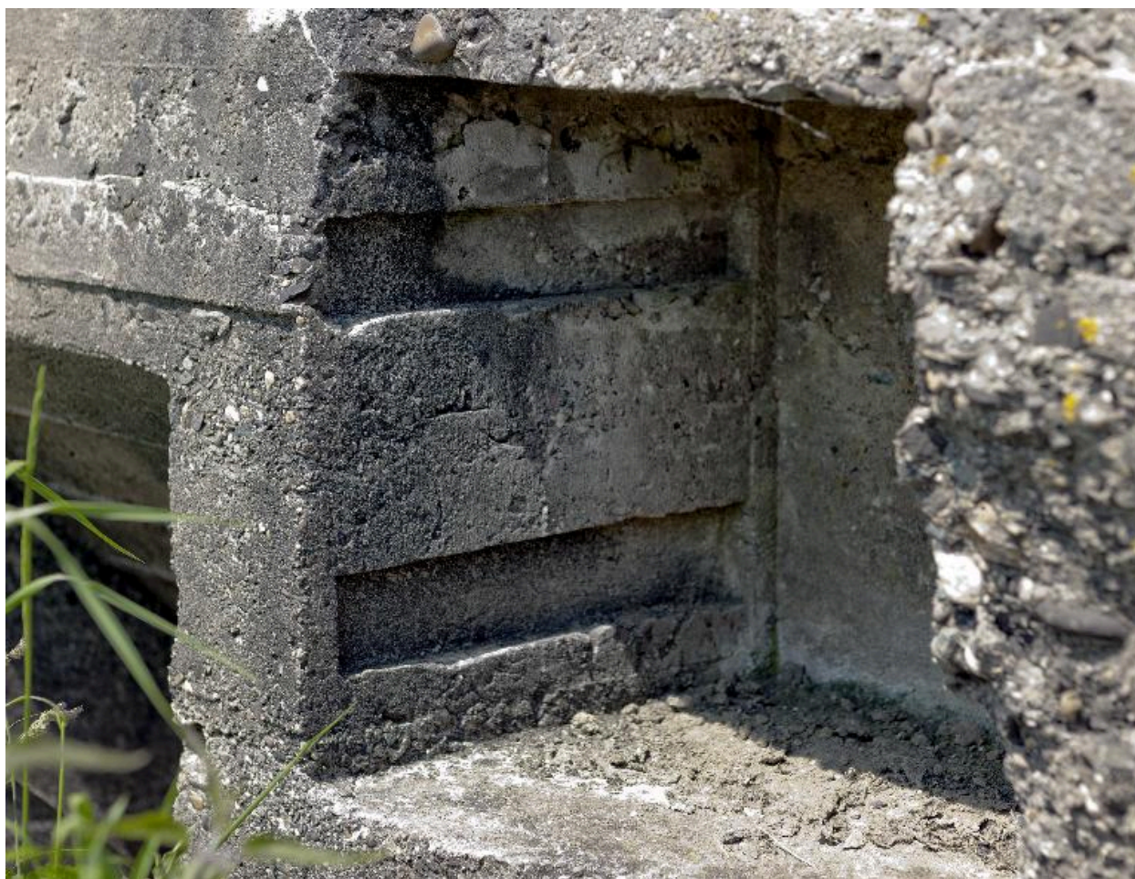
Niches à munitions. Les rainures correspondent à l'empreinte de la caisse ayant servi de gabarit
