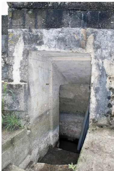
Entrée est Phot. Pierre Thibaut IVR31_20155901483NUCA
