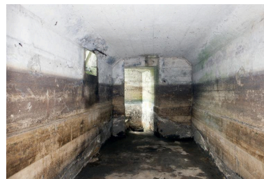
Salle ouest Phot. Pierre Thibaut IVR31_20155901479NUCA
