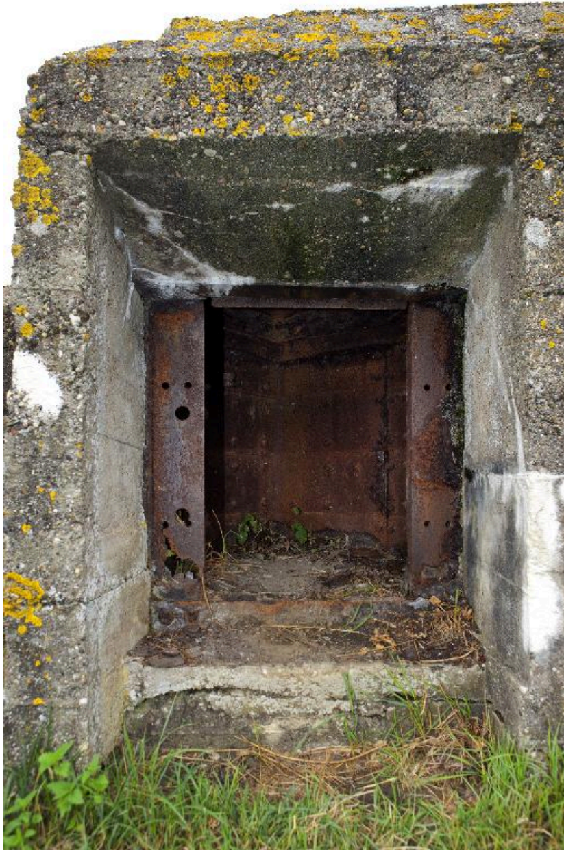
Entrée de l'observatoire casematé.
