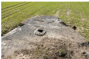
Couvreur, cheminée du périscopie Phot. Jean-Marc Ramette IVR31_20145904685NUCA
