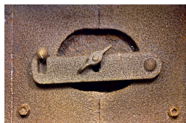
Observatoire casematé, dispositif de verrouillage. Phot. Jean-Marc Ramette IVR31_20145904697NUCA
