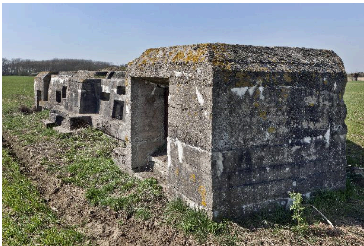
Vue de trois-quarts vers le nord-ouest
