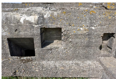
De gauche à droite : Conduit d'aération (?) et niches à munitions Phot. Jean-Marc Ramette IVR31_20145904690NUCA
