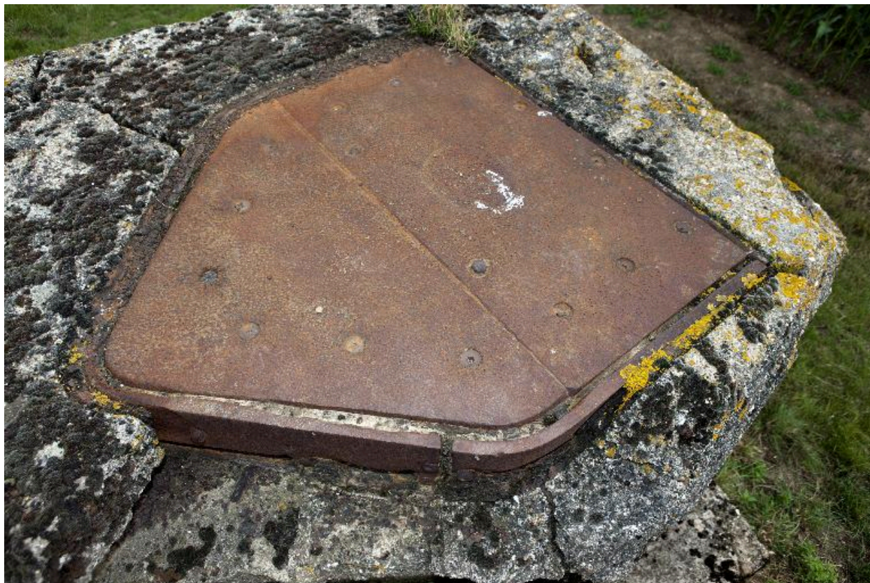
Observatoire bétonné, couvrement
