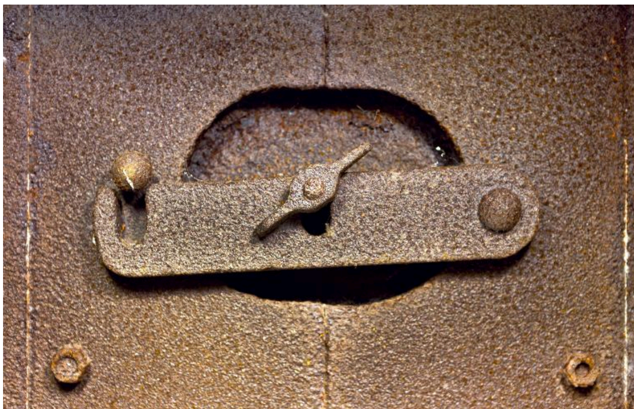
Observatoire casematé, dispositif de verrouillage.
