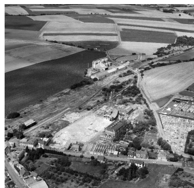
Vue aérienne, flanc sud-ouest. Phot. Phot'R IVR22_19888001289P
