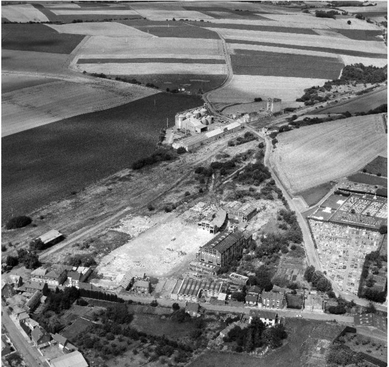
Vue aérienne, flanc sud-ouest.
