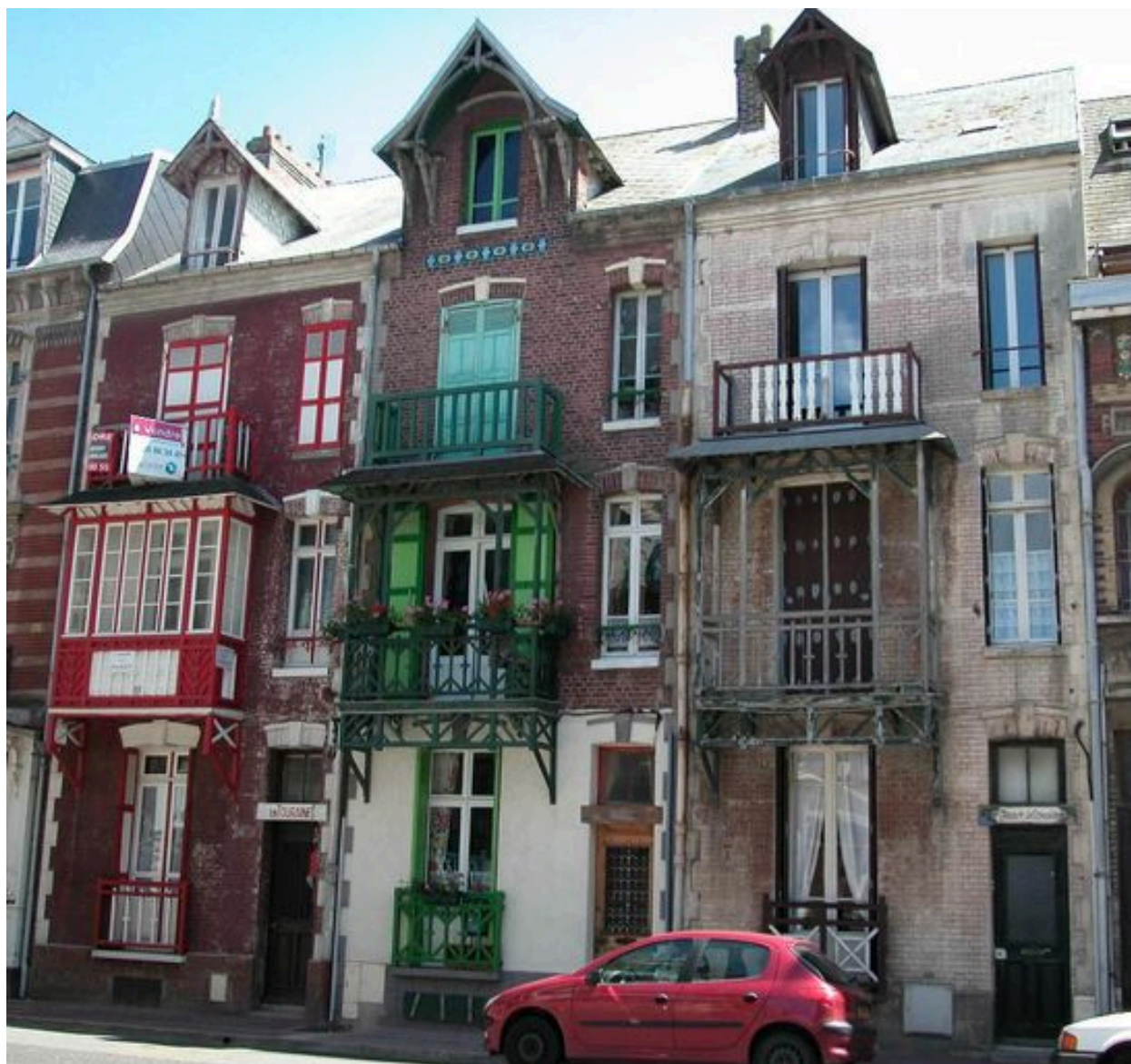
Elévation à 3x2 travées (10, 12, 14 avenue du Maréchal-Foch).
