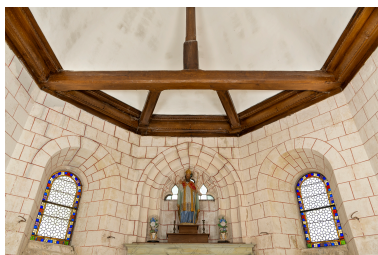
Charpente du sanctuaire. Phot. Marc Kérignard IVR32_20256000525NUCA
