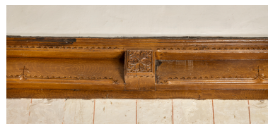
Poutre sablière et blochet sculpté de la première travée du chœur (côté sud). Phot. Marc Kérignard IVR32_20256000529NUCA
