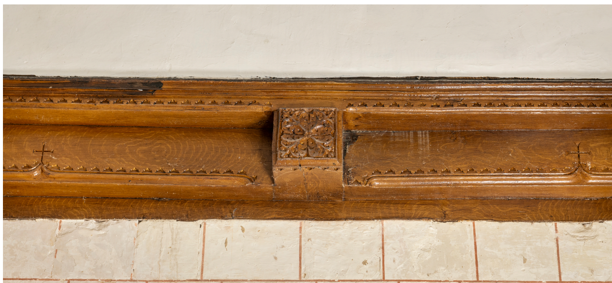
Poutre sablière et blochet sculpté de la première travée du chœur (côté sud).
