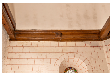
Poutre sablière et blochet sculpté dans la première travée du chœur (côté nord). Phot. Marc Kérignard IVR32_20256000527NUCA
