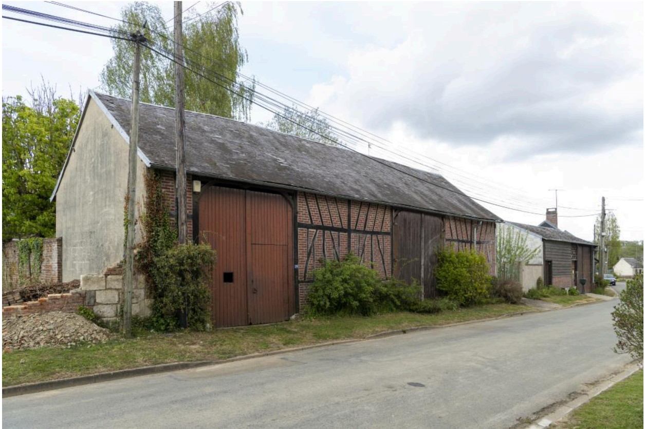
Grange et entrée charretière alignés sur la rue, n°29 Grande Rue, vue depuis le sud-ouest.
