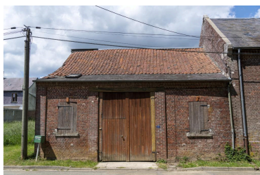
Logis et entrée charretière sur rue, n°41 Grande Rue, vue depuis le sud. Phot. Marc Kérignard IVR32_20216000641NUCA
