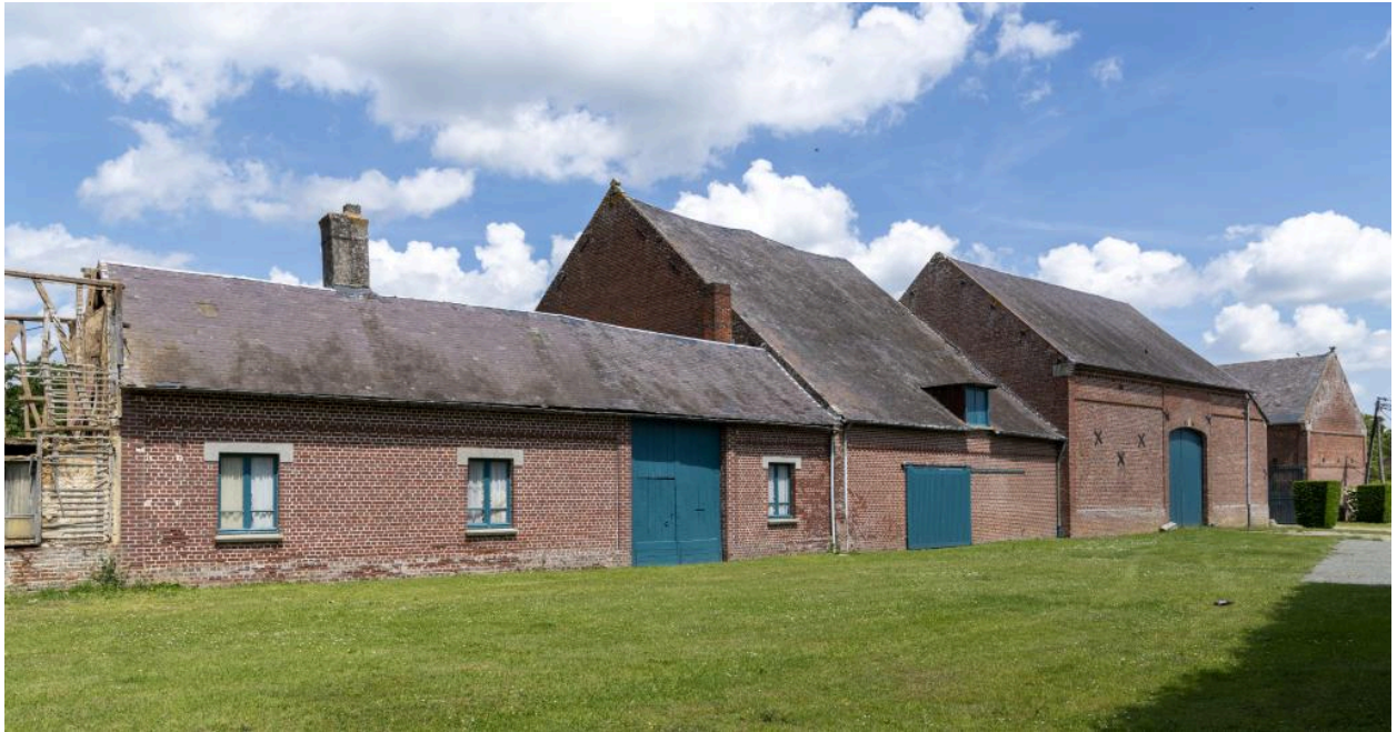
Logis, bâtiment agricole et grange de la ferme au n°3 rue Babeur, vue depuis le sud-ouest.
