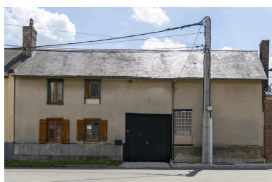
Logis sur rue avec entrée charretière et grange (porte
