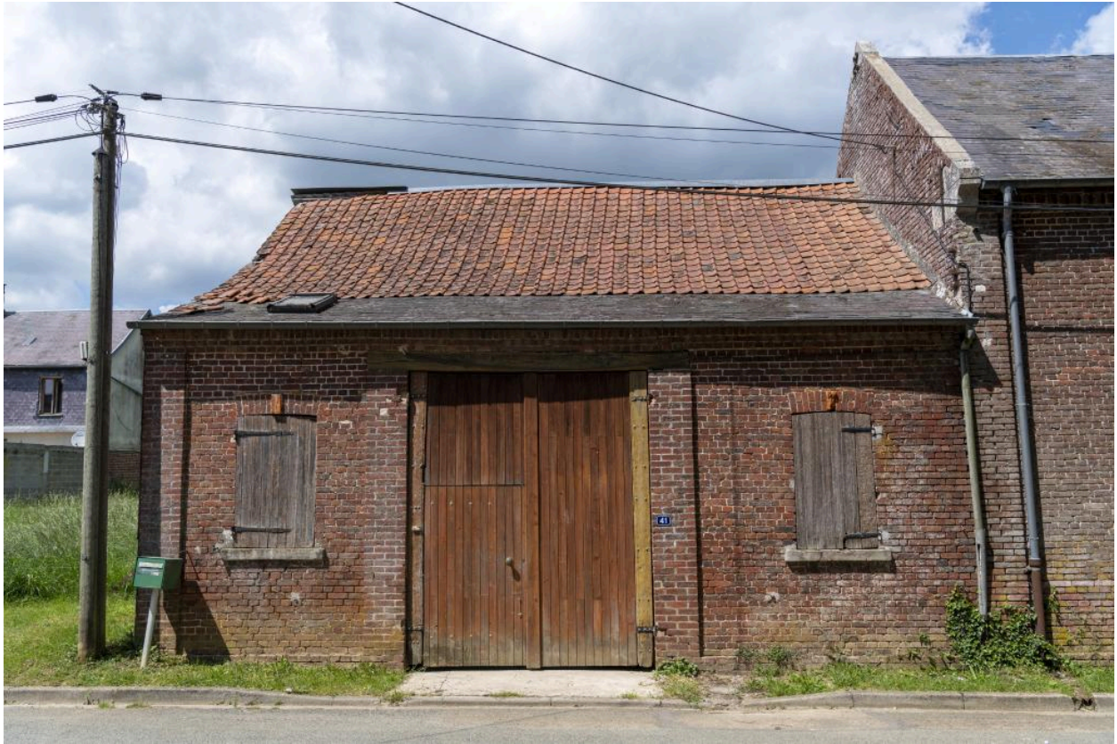
Logis et entrée charretière sur rue, n°41 Grande Rue, vue depuis le sud.
