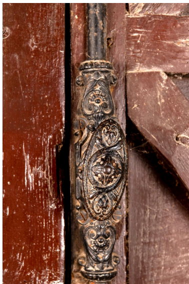
Porte d'entrée, détail des ferronneries, 19e siècle. Phot. Marc Kérignard IVR32_20226001026NUCA
