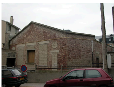
L'ancien casino provisoire, actuelle salle des fêtes, vue postérieure.
