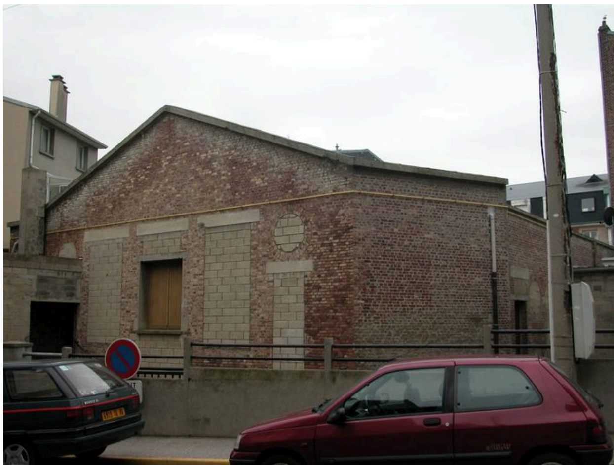
L'ancien casino provisoire, actuelle salle des fêtes, vue postérieure.
