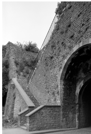
Vue de profil sur escalier. Phot. Jean-Michel Périn, Phot. Éric Dessert IVR31_19806203070X
