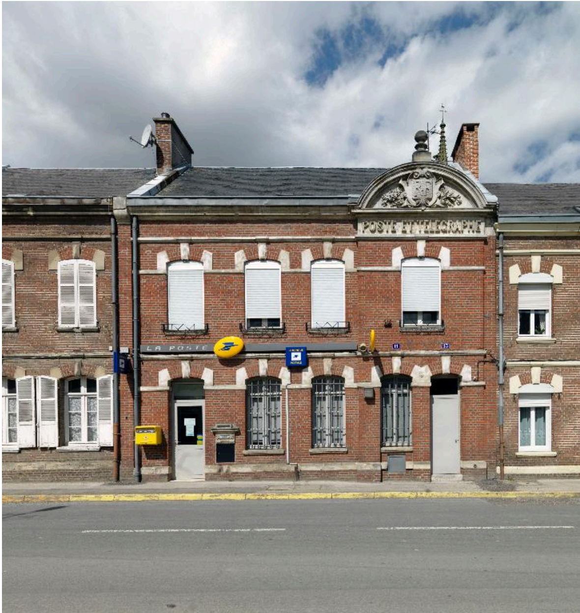
Vue d'ensemble sur rue.
