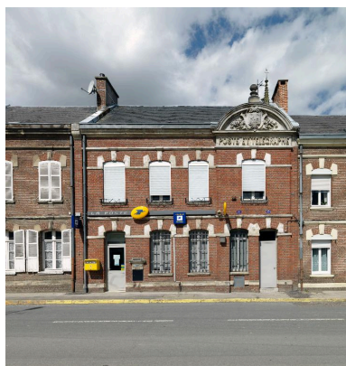
Vue d'ensemble sur rue.
