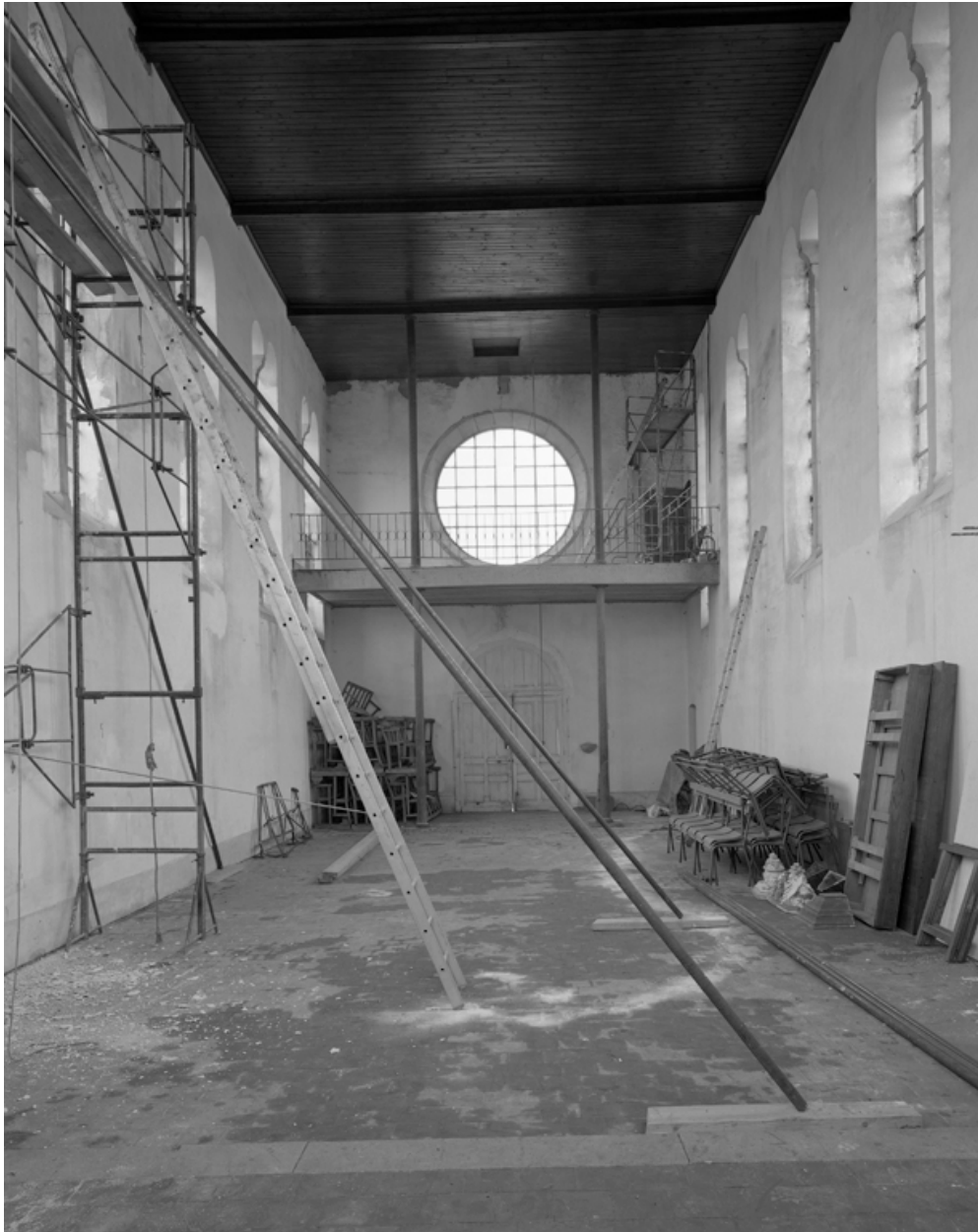
Vue intérieure de la nef (en cours de restauration) depuis le chœur vers l'entrée.
