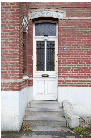
Détail de l'entrée de la villa Saint-Charles à Bavinchove. Phot. Delphine Volto Jourdan IVR32_20245903230NUCA
