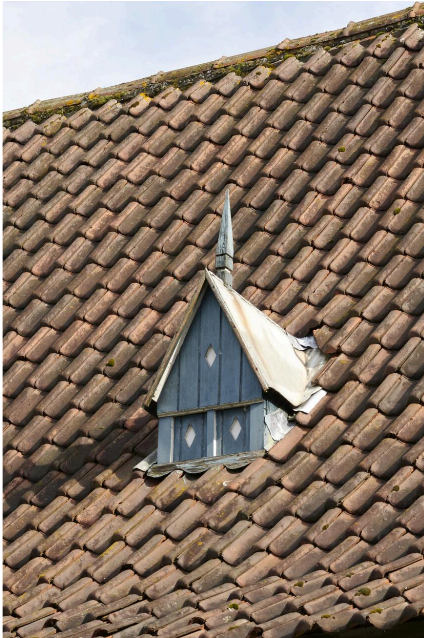
Détail d'une lucarne d'une ferme de Rubrouck.
