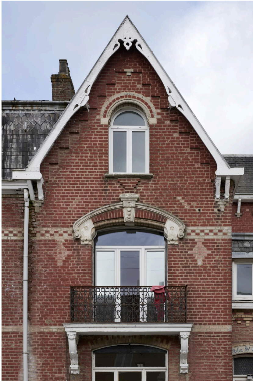
Détail de la façade la villa Saint-Charles à Bavincove.
