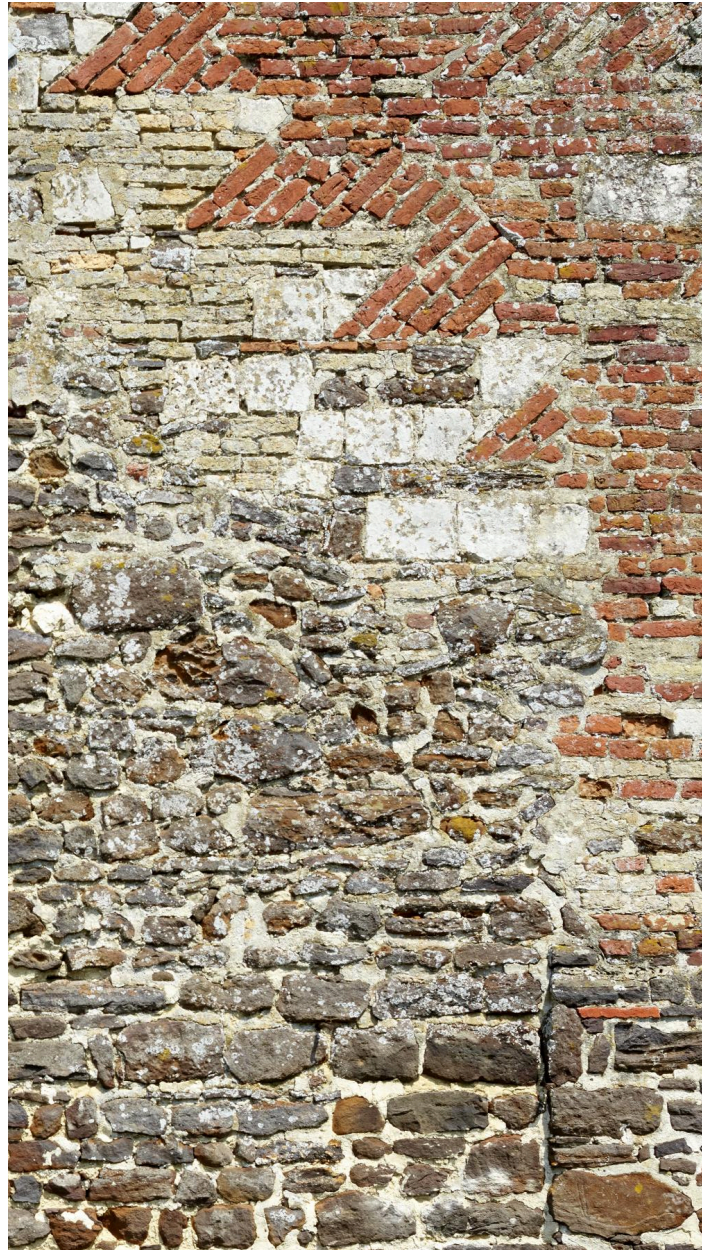
Détail des matériaux qui composent les élévations de l'église de Zermezele.
