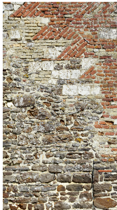
Détail des matériaux qui composent les élévations de l'église de Zermezele. Phot. Delphine Volto Jourdan IVR32_20235900719NUCA
