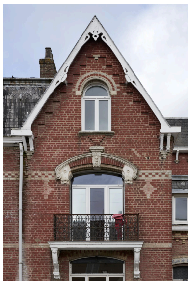
Détail de la façade la villa Saint-Charles à Bavinchove. Phot. Delphine Volto Jourdan IVR32_20245903229NUCA
