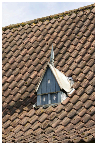
Détail d'une lucarne d'une ferme de Rubrouck. Phot. Delphine Volto Jourdan IVR32_20255900803NUCA
