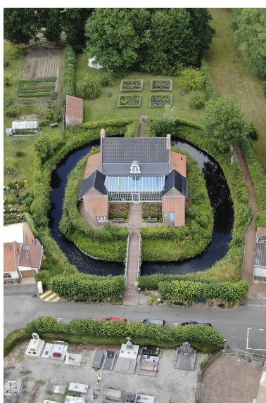
Vue aérienne de la mairie de Rubrouck. Phot. Delphine Volto Jourdan IVR32_20255901395NUCA
