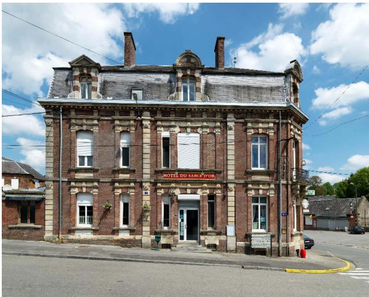
Façade de la rue de l'Eglise.
