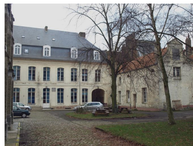
Façade arrière, et bâtiment annexe en retour d'angle Phot. Bruno Decrock IVR31_20106202970NUCA
