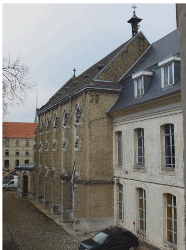
Bâtiment administratif et chapelle Phot. Bruno Decrock IVR31_20106202971NUCA
