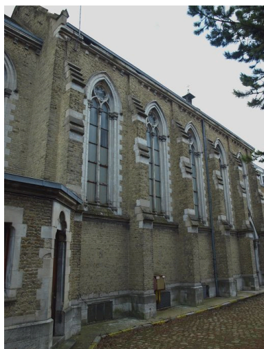
Chapelle : murs latéraux Phot. Bruno Decrock IVR31_20106202972NUCA
