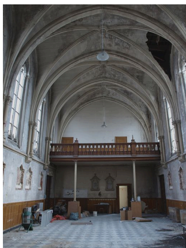
Chapelle, intérieur : nef, vue vers le mur ouest, plaques de consécration sous la tribune. Phot. Bruno Decrock IVR31_20106202975NUCA
