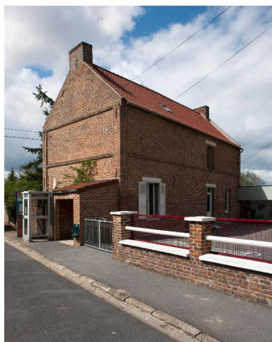
Vue générale de l'ancien logis, transformé en salle de classe. Phot. Pierre Thibaut IVR31_20125901623NUCA
