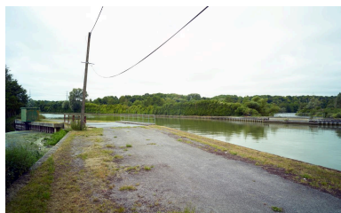
Vue depuis la rive est. Voie de circulation sur le pont canal.
