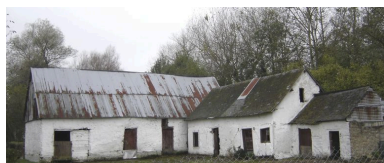
Vue générale. Phot. Inès Guérin IVR22_20068005864NUCA
