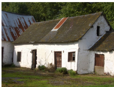
Vue détaillée du logis. Phot. Inès Guérin IVR22_20068005865NUCA
