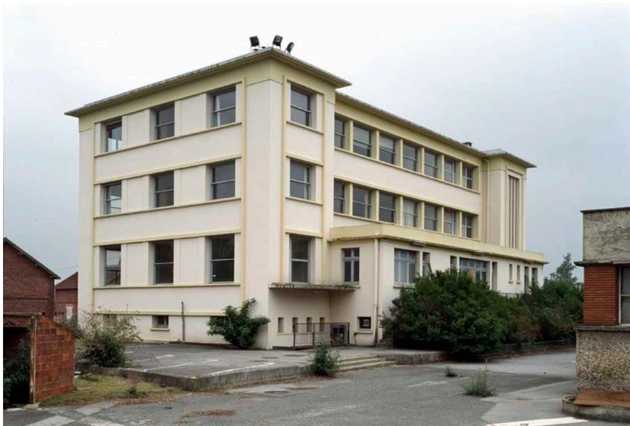
Façades nord-est du bâtiment administratif et social.
