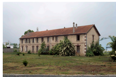
Ancienne cantine. Phot. Thierry Lefébure IVR22_20106000195XA
