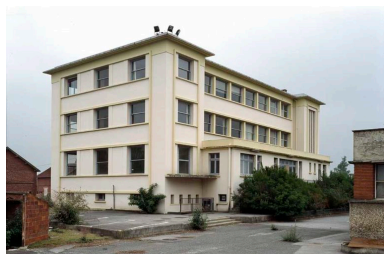
Façades nord-est du bâtiment administratif et social. Phot. Thierry Lefébure IVR22_20106000193XA
