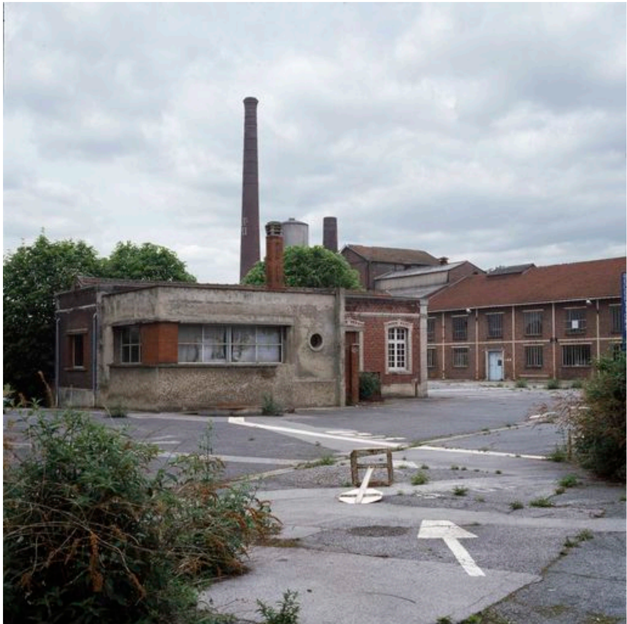
Ancienne bâtiments des douches et buanderie.
