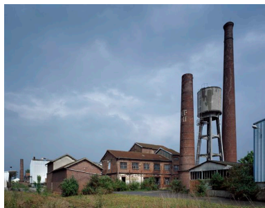
Vue du site depuis l'ouest : les cheminées dont la plus haute mesure 30 mètres portent les initiales du fondateur de l'usine Antoine Thibault et la date 1911.
