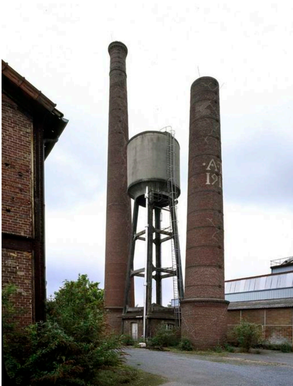
Ensemble de deux cheminées encadrant le château d'eau.
