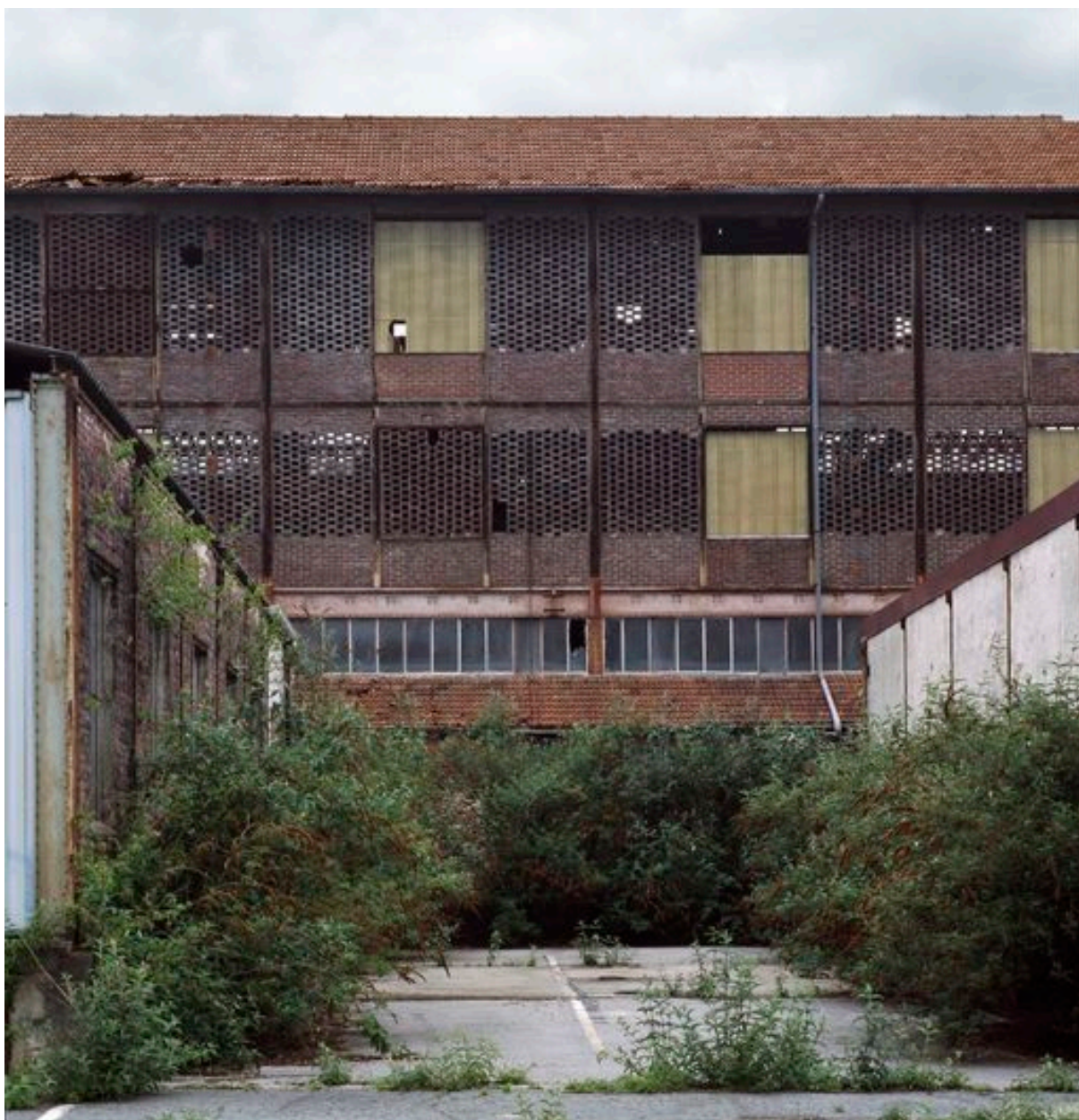
Détail de l'atelier d'emballage et de sa façade à claire-voie.
