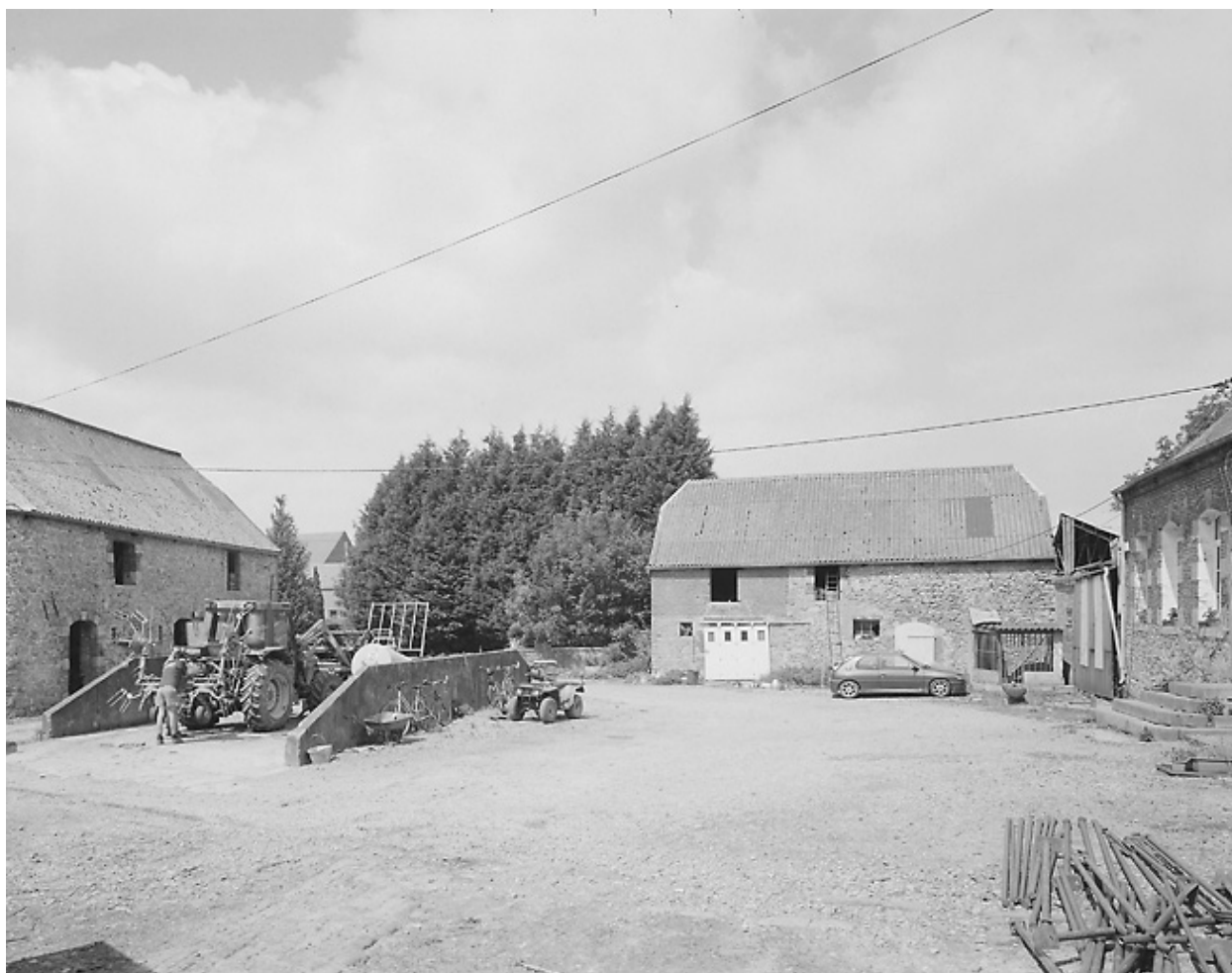
Vue des bâtiments d'exploitation.
