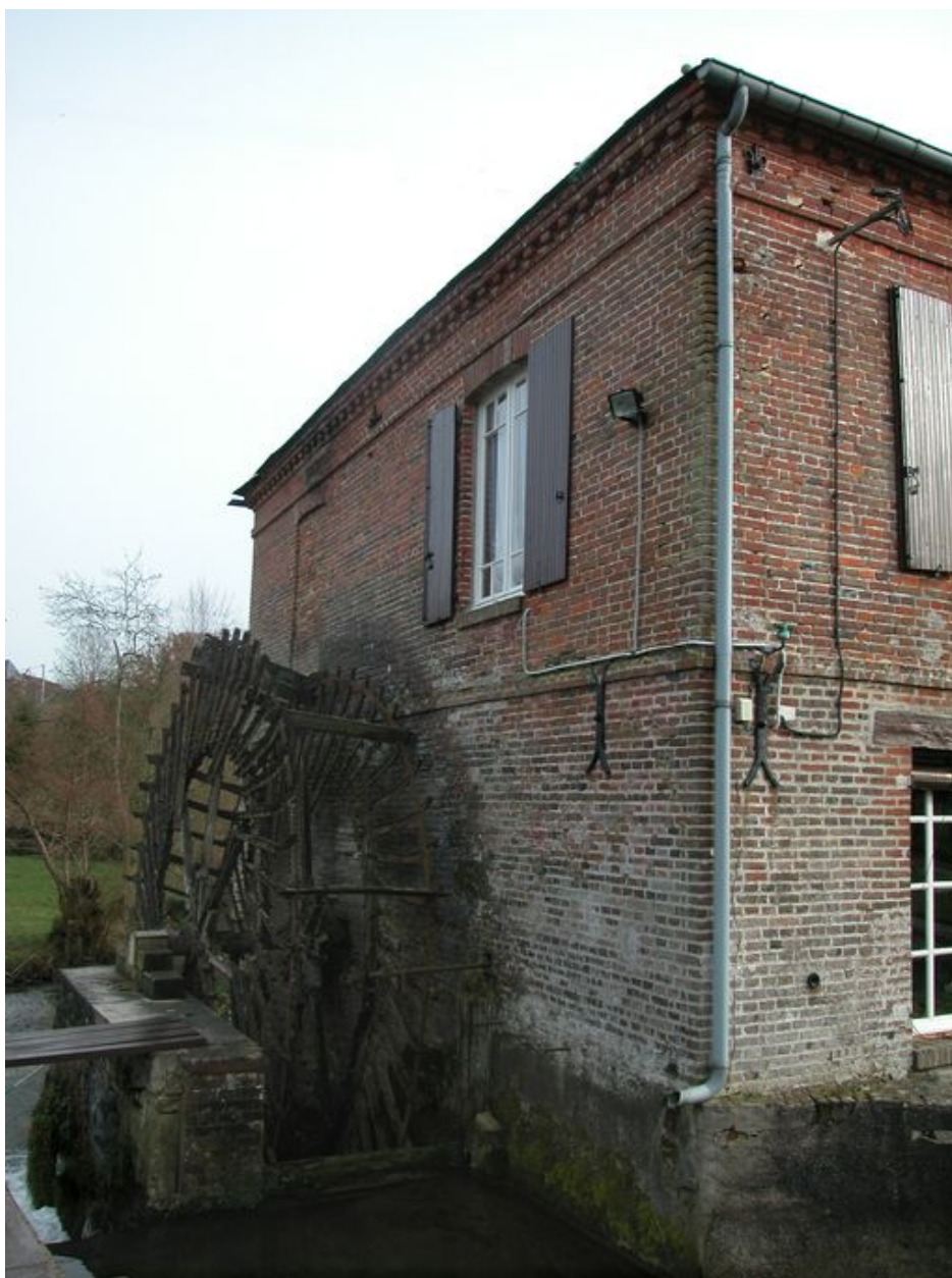
La roue hydraulique, vue de trois-quarts.
