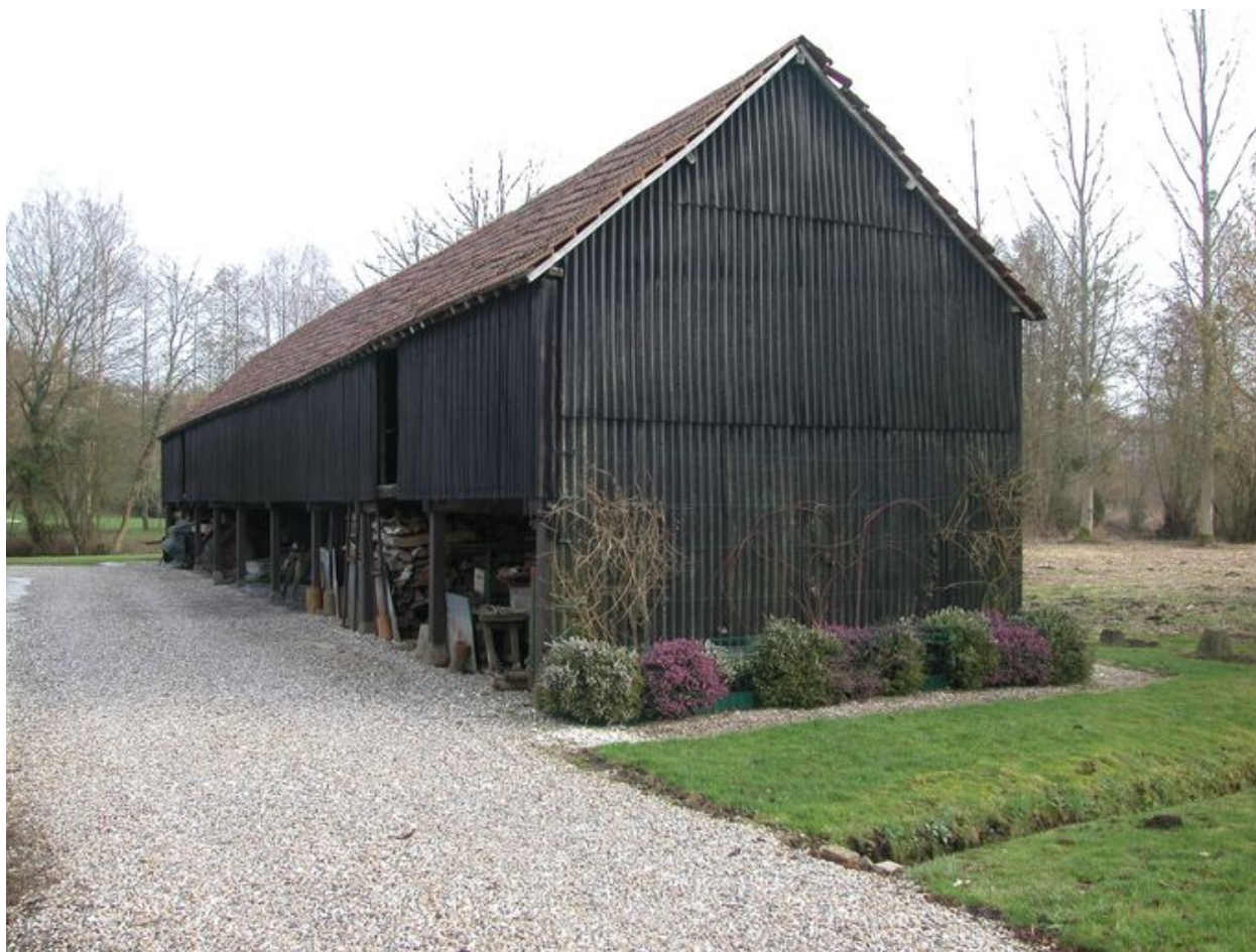
Bâtiment de stockage des bois, vue d'ensemble.
