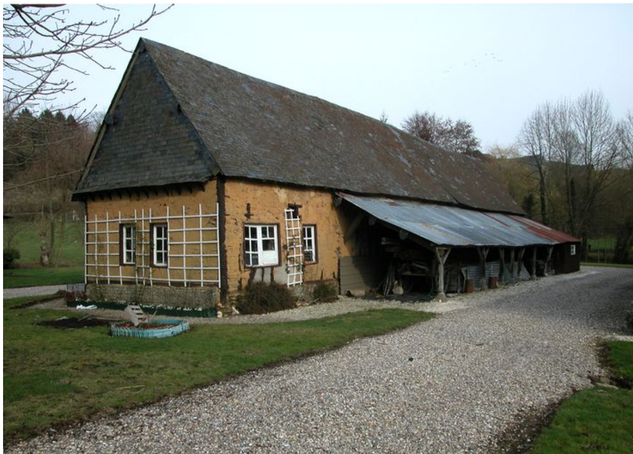
Atelier de montage des caisses, vue d'ensemble.
