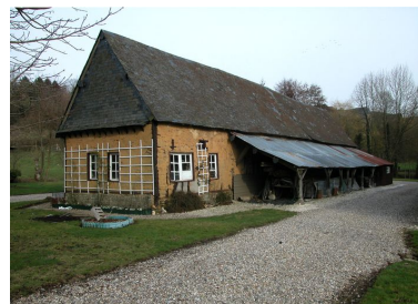
Atelier de montage des caisses, vue d'ensemble.
