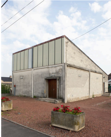
Élévation antérieure et flanc droit.
