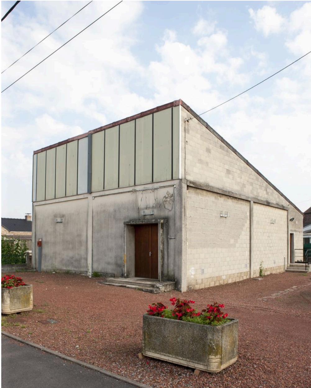
Élévation antérieure et flanc droit.
