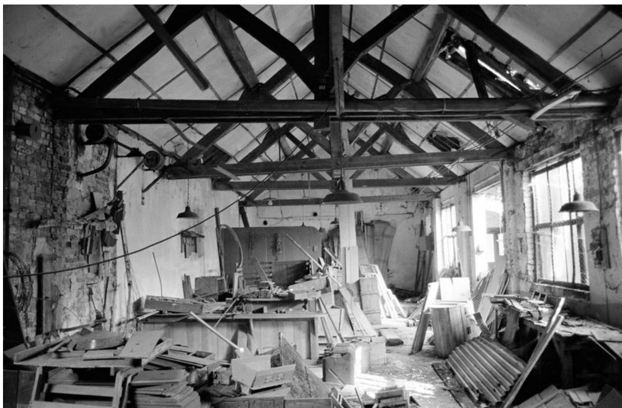
Intérieur du grand atelier de fabrication.
