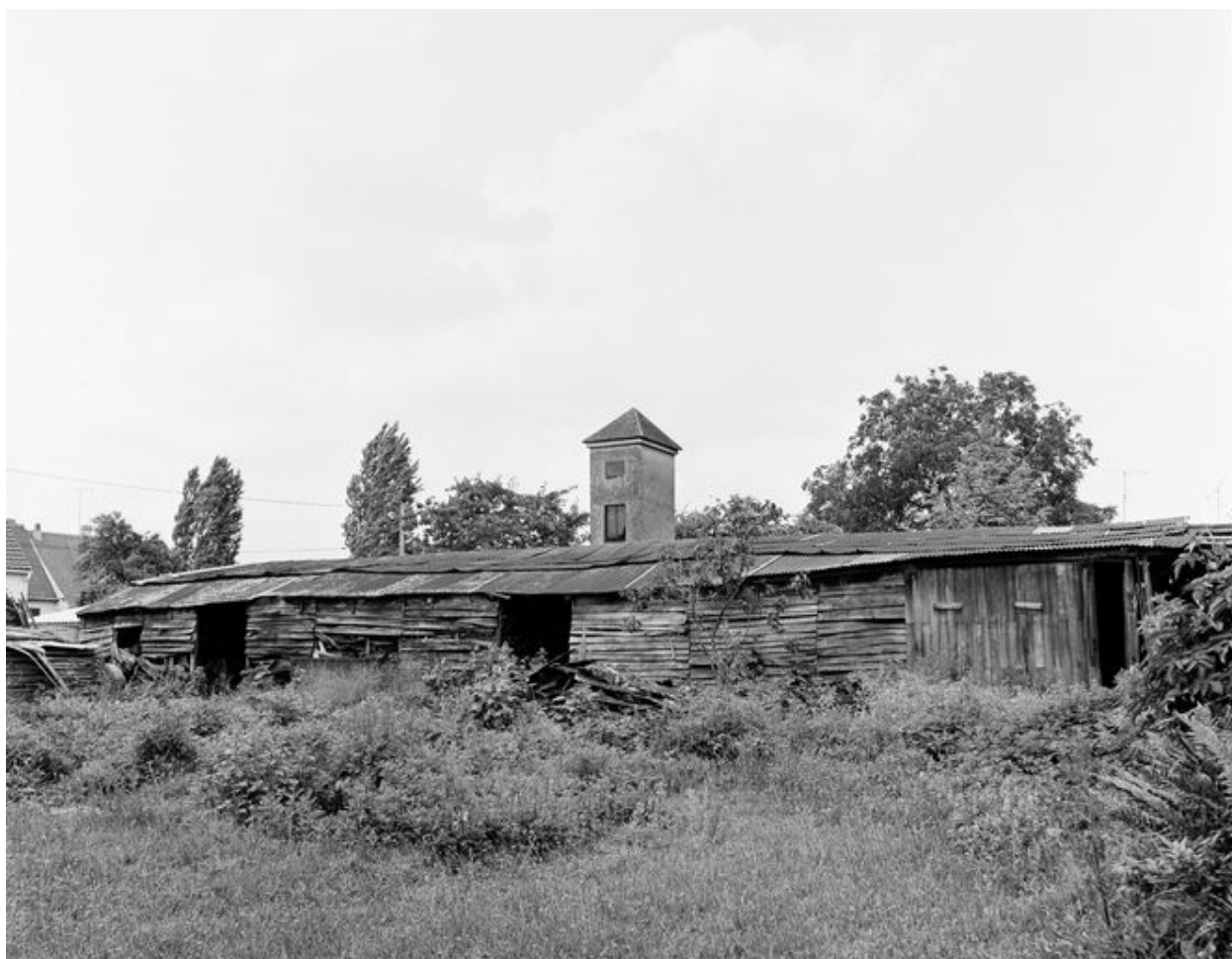
Remise et entrepôt industriel.
