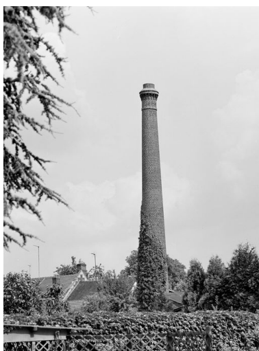
Cheminée d'usine. Phot. Patrick Glotain IVR22_19936000733X
