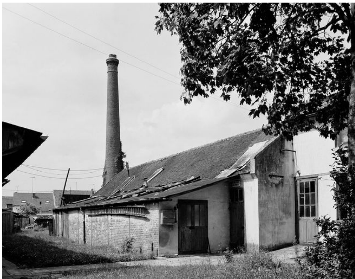
Atelier de fabrication et cheminée d'usine.
