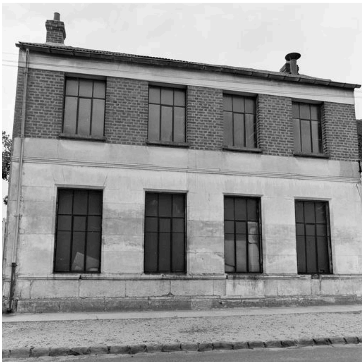
Atelier de fabrication, élévation antérieure.
