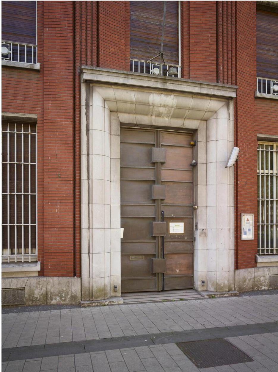
Vue de la porte d'entrée place Jean-Bart.
