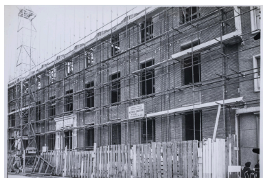
Dunkerque. Succursale de la Banque de France. Façade en construction, photographie noir et blanc, [ca 1953] (AC Dunkerque, fonds Morel (non coté)). Repro. Pierre Thibaut IVR32_20255901369NUCA
