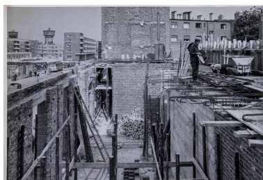
Dunkerque. Succursale de la Banque de France. Chantier de construction, photographie noir et blanc, [ca 1953] (AC Dunkerque, fonds Morel (non coté)). Repro. Pierre Thibaut IVR32_20255901370NUCA
