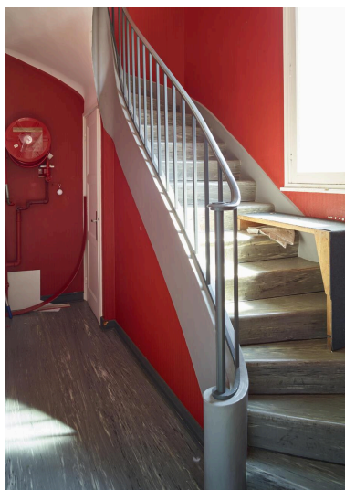
Premier étage, logement du caissier, escaliers vers le deuxième étage.
