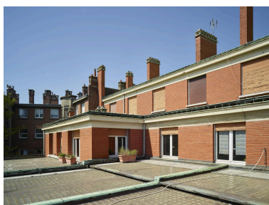
Vue de la fa ade sur cour et de la verri re du hall d'accueil. Phot. Pierre Thibaut IVR32_20255900716NUCA
