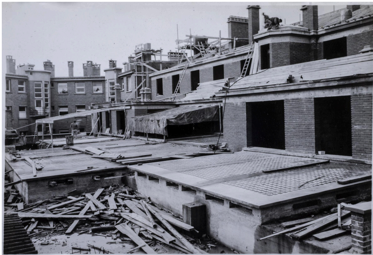
Dunkerque. Succursale de la Banque de France. Chantier de construction, côté cour, photographie noir et blanc, [ca 1953] (AC Dunkerque, fonds Morel (non coté)).
