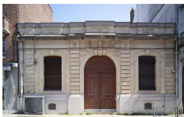
Vue de l'entr e rue Nationale. Phot. Pierre Thibaut IVR32_20255900687NUCA
