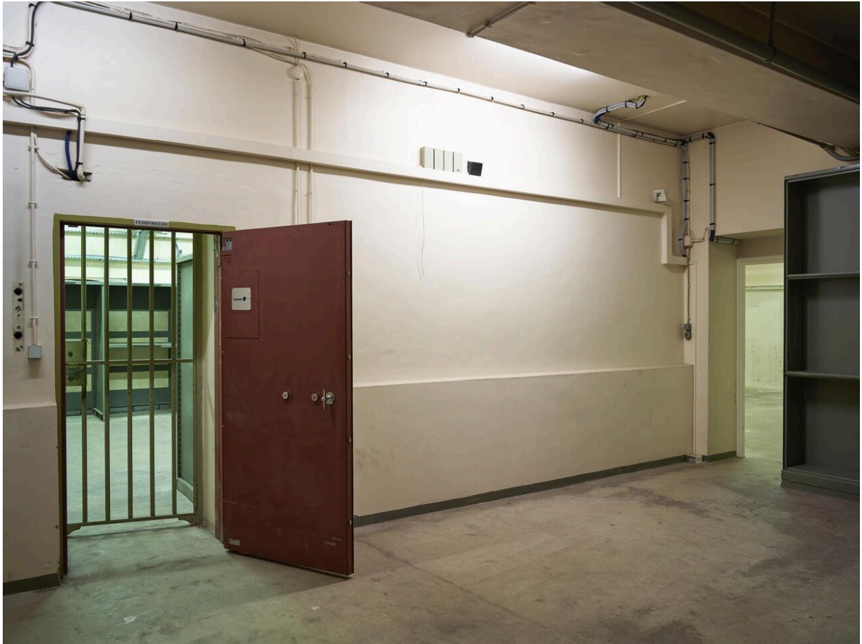
Sous-sol, passage entre la serre n°3 et n°5.
