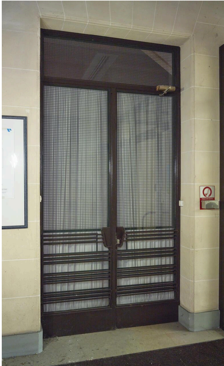
Rez-de-chaussée. Porte située entre l'entrée publique et le vestibule de l'escalier menant aux logements.
