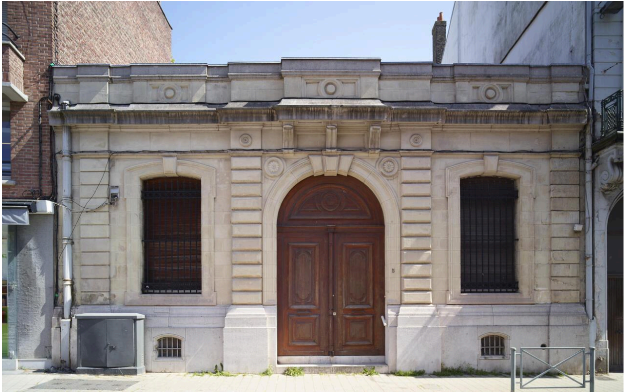
Vue de l'entrée rue Nationale.
