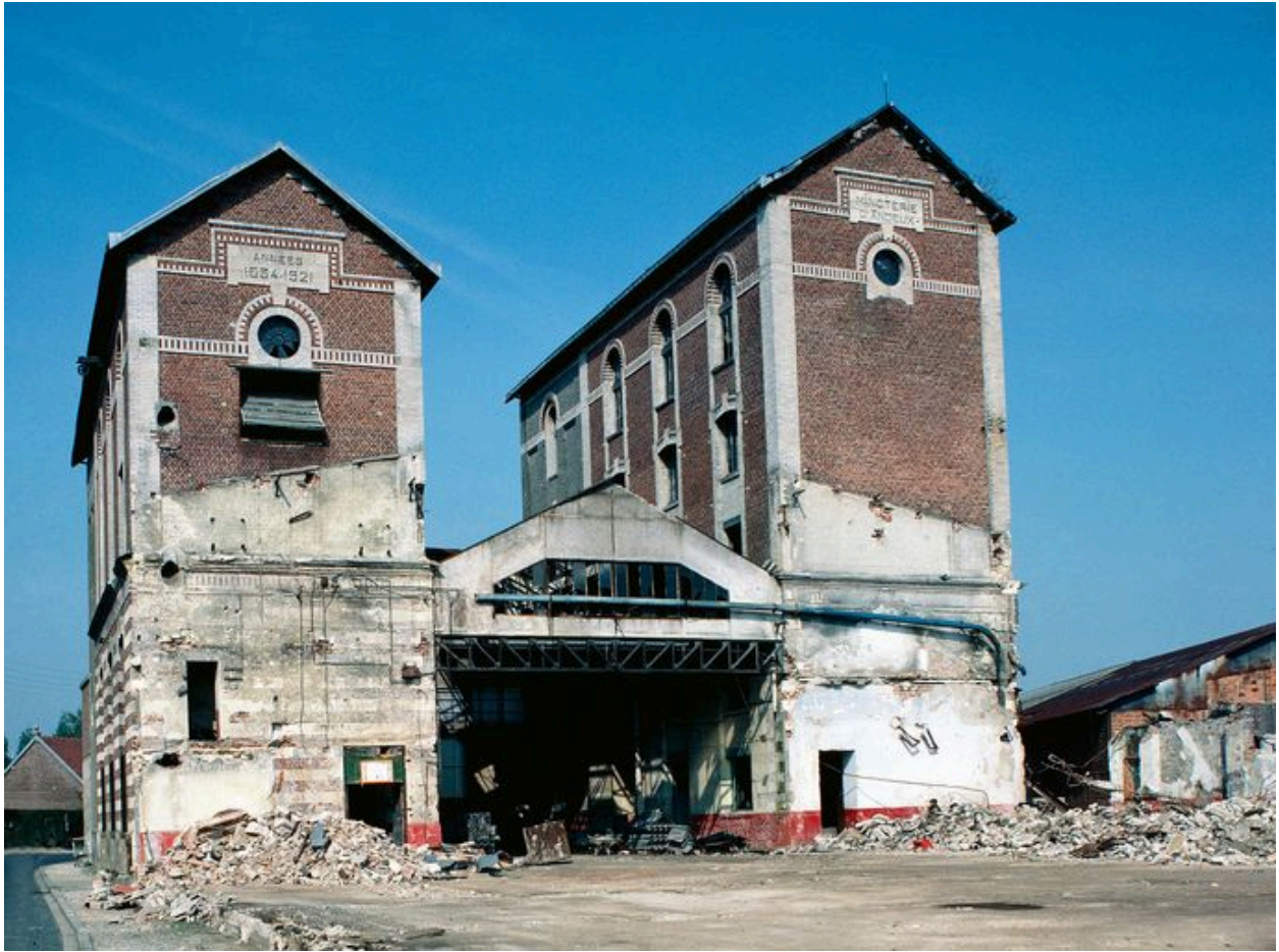
Vue en cours de destruction.
