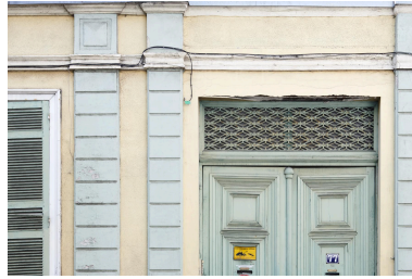
Détail de l'annexe : garage, ferronnerie et pilastres. Phot. Delphine Volto Jourdan IVR32_20265900028NUCA
