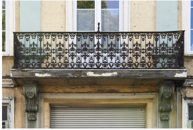
Balcon de la travée centrale munie d'une rambarde en fer forgé. Phot. Delphine Volto Jourdan IVR32_20265900026NUCA
