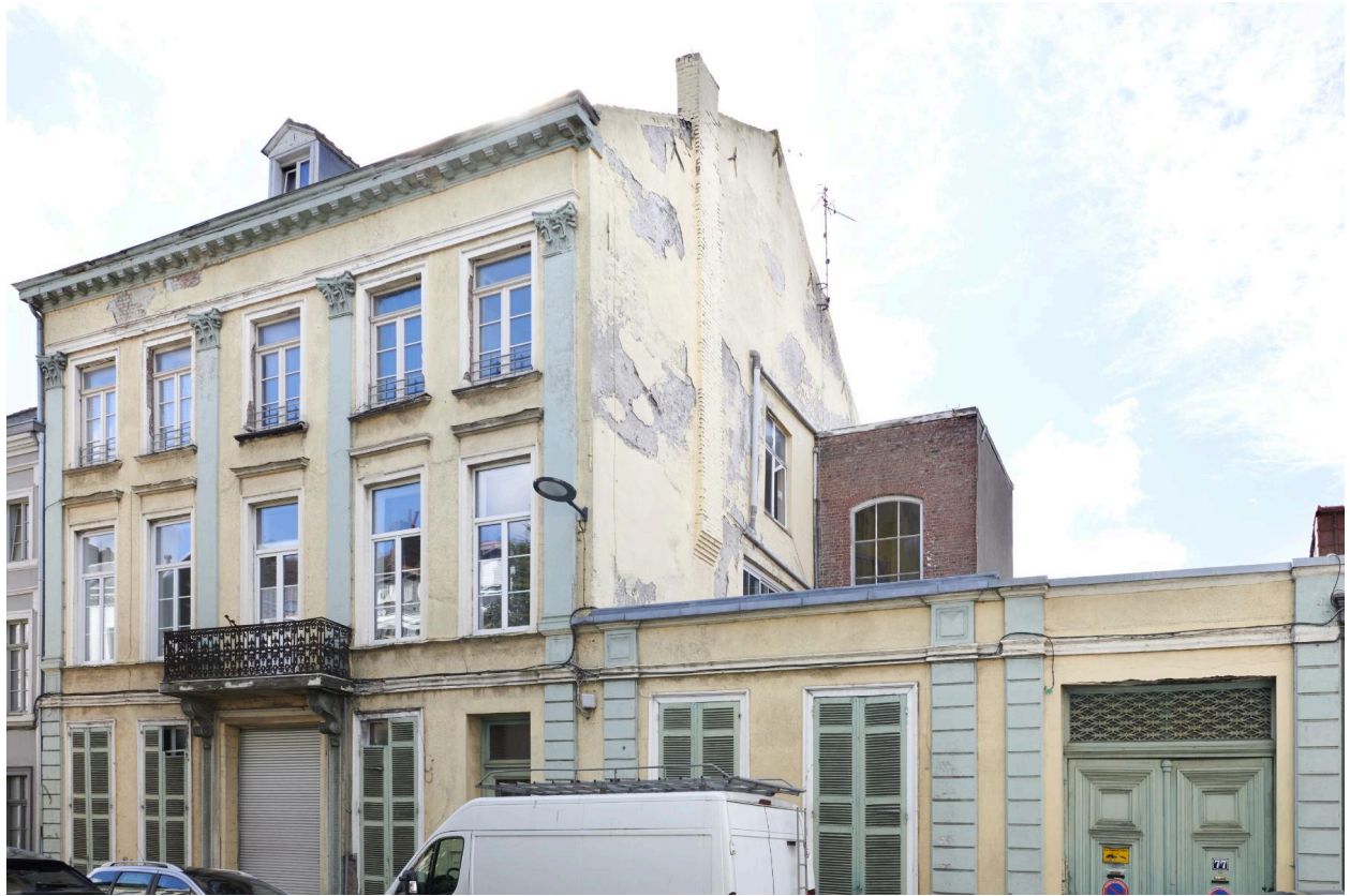
Vue générale de l'ensemble avec annexe.
