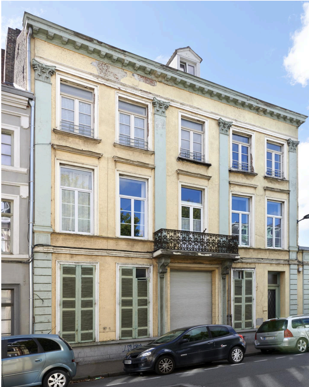
Vue générale de la façade.
