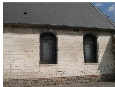
Fenêtres du chœur (mur sud). Phot. Isabelle Barbedor IVR22_20038011009NUCA
