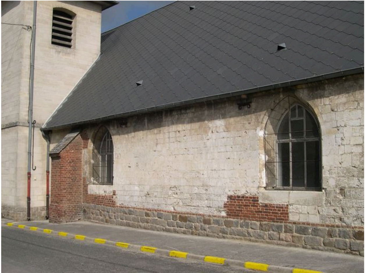
Fenêtres de la nef (mur sud).
