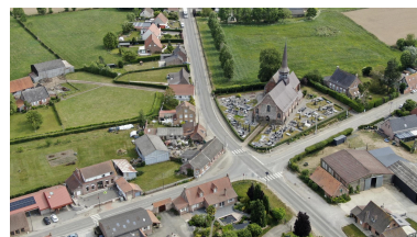
Vue aérienne oblique du cimetière. Phot. Delphine Volto Jourdan IVR32_20255901273NUCA
