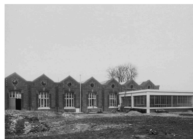
Crèche de l'usine de Beauval, attenante aux bureaux, Jean-Pierre Jacquart (photographe), 1937.
