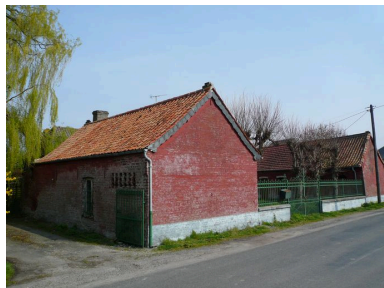
Vue générale depuis l'ouest. Phot. Inès Guérin IVR22_20078005701NUCA
