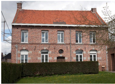
Vue générale de l'élévation postérieure. Phot. Pierre Thibaut IVR31_20125901617NUCA
