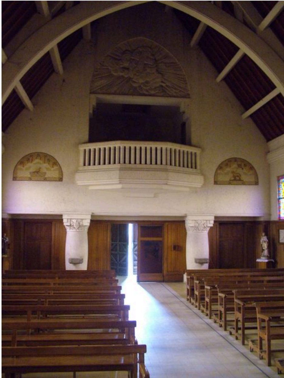
Vue intérieure du mur ouest.
