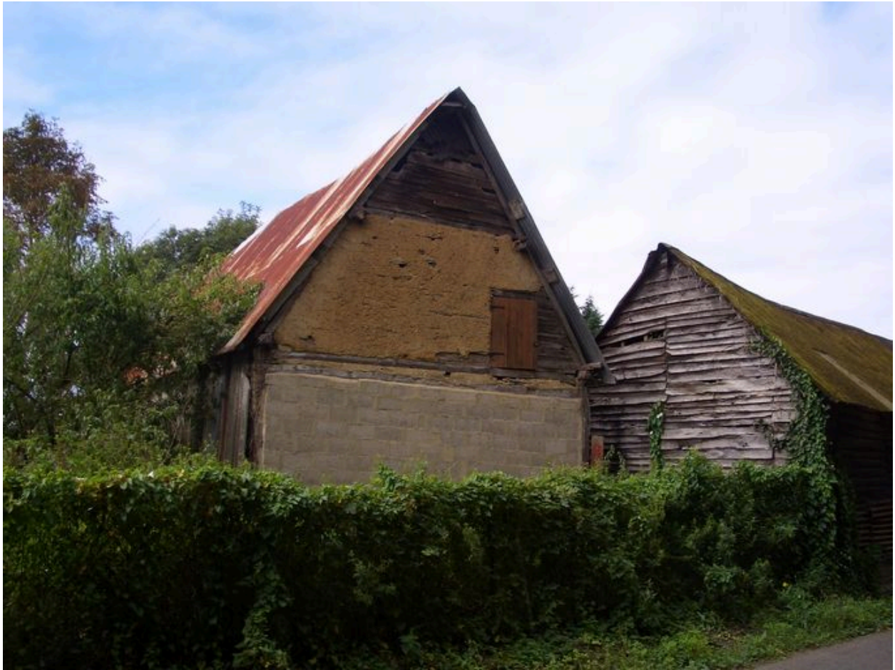
Vue du pignon en torchis et pans de bois du bâtiment en fond de cour.
