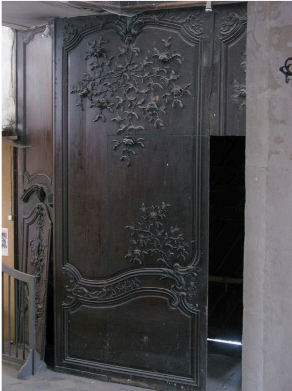
Vue partielle, porte de gauche
