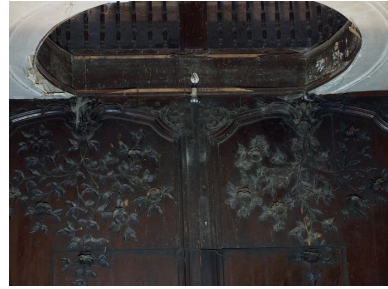
Vue de détail, partie supérieure Phot. Bruno Decrock IVR31_20106202001NUCA
