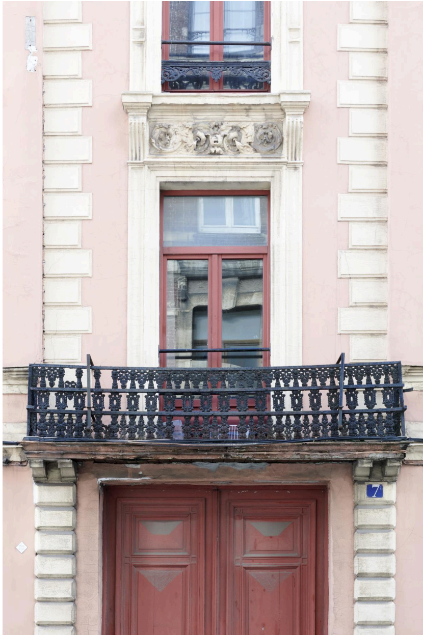
Pilastres apparents, décors floraux moulurés sur la console du deuxième étage, balcon avec ferronnerie sur la travée centrale.
