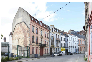
Vue de trois quarts et pignon. Phot. Delphine Volto Jourdan IVR32_20265900015NUCA
