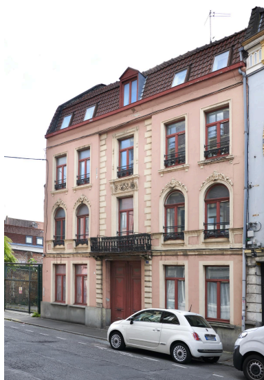
Vue générale de la façade. Phot. Delphine Volto Jourdan IVR32_20265900014NUCA
