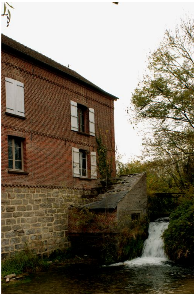
Façade nord du moulin et la chute.
