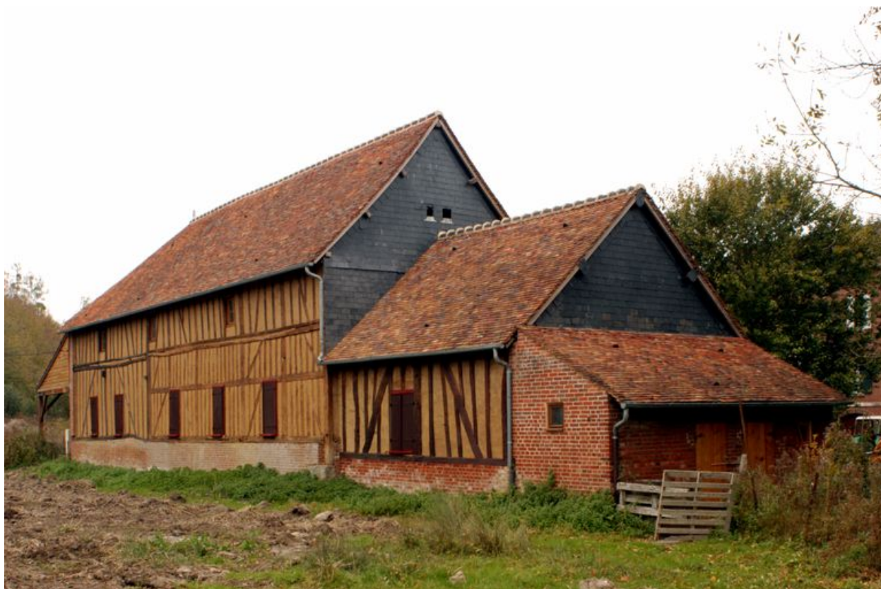
Vue d'ensemble sud-ouest de la grange.
