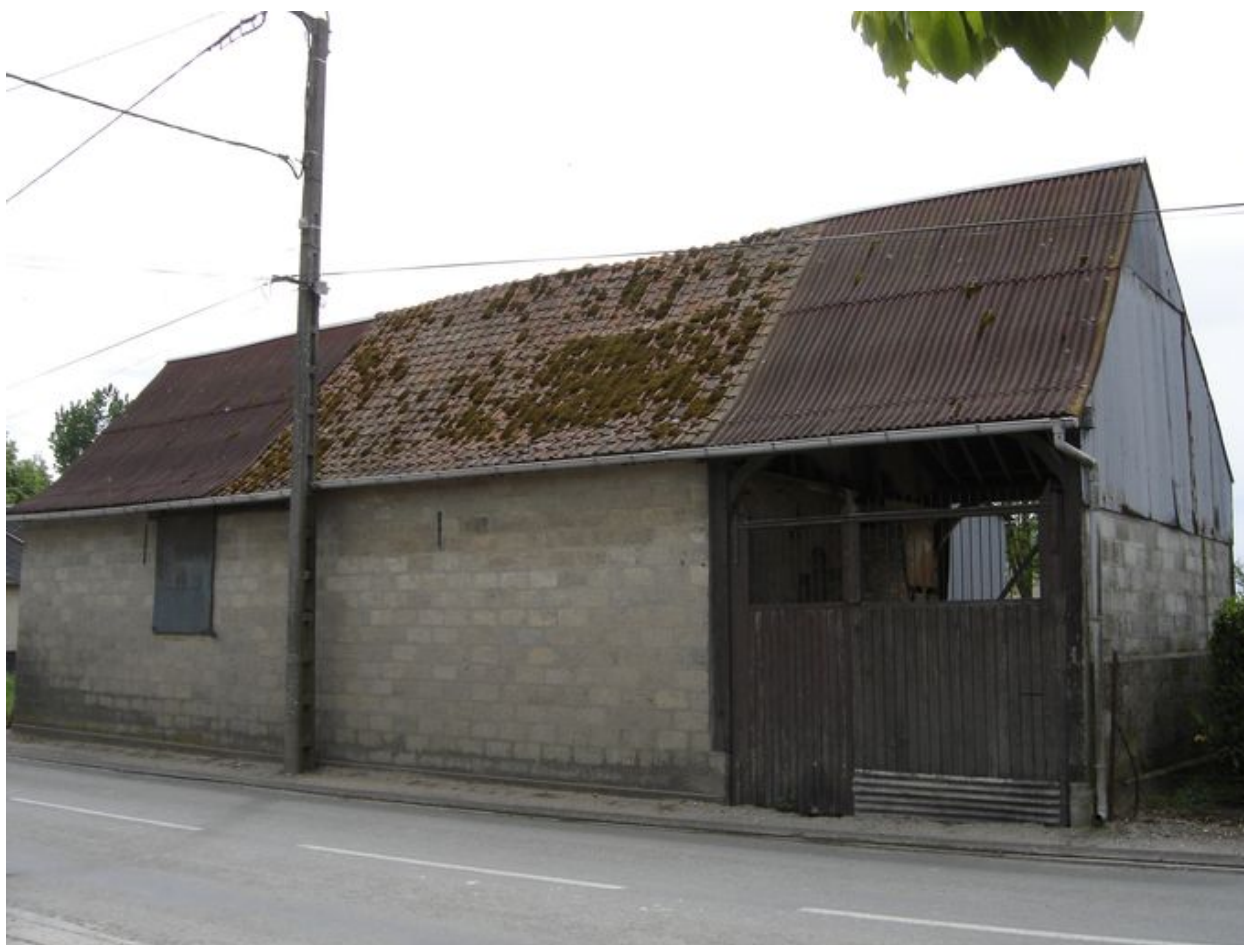
Vue générale de la grange.
