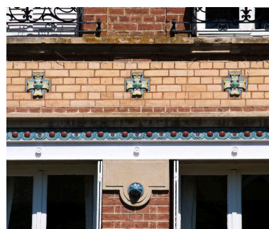
Détail du bandeau de séparation de niveau, orné de céramiques vernissées. Phot. Thierry Lefébure IVR22_20138000188NUC2A
